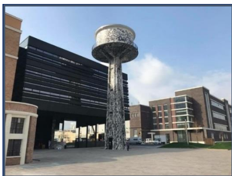
NOI Techpark Bozen Quelle: NOI AG
