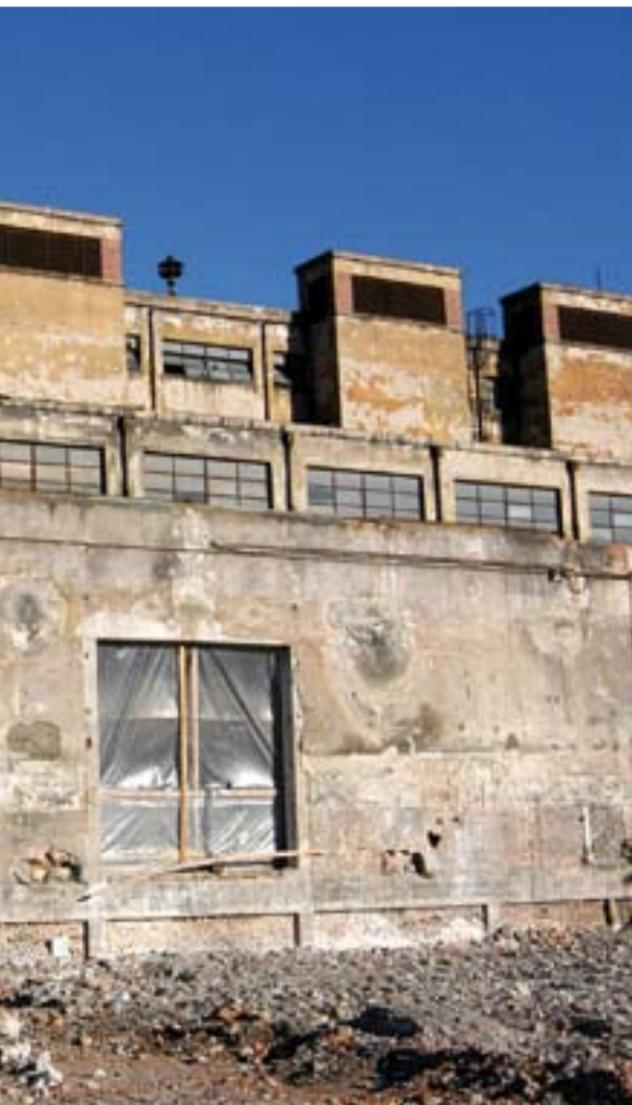
Die auffälligen Aufsätze am Dach der inzwischen abgerissenen Ofenhalle gehörten zu einem raffinierten Lüftungssystem.
