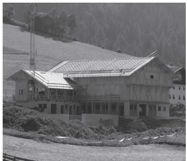
Wirtschaftsgebäude im Sarntal
