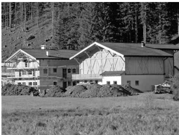
Neubau Wirtschaftsgebäude und Wohnhaus
