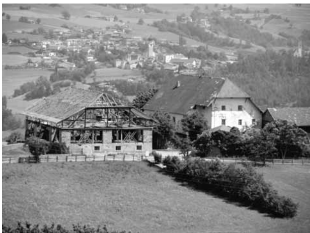
Wiederaufbau eines Wirtschaftsgebäudes
