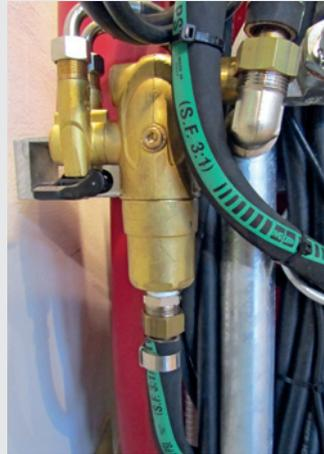
Eine automatische Innenreinigung des Druckfilters ist notwendig.
