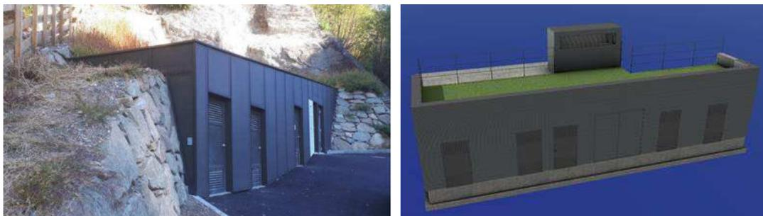
**Figura 48.** Esempio del rivestimento scelto per la cabina elettrica e rendering della stessa.
