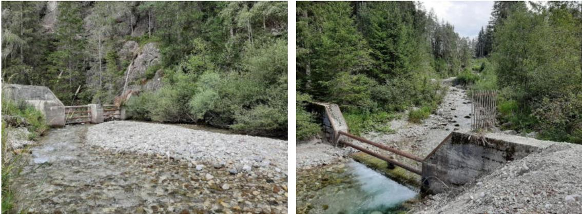
**Figura 44.** Alcune immagini delle briglie filtranti esistenti lungo il Rio di Sesto nei pressi del sito in cui è prevista la realizzazione dell'opera di diversione e del portale Sud del nuovo tunnel stradale.
