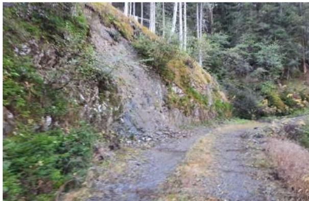
*Kleinräumige Translationsrutschung direkt nach der Querung des Reipertingerbachs.*
