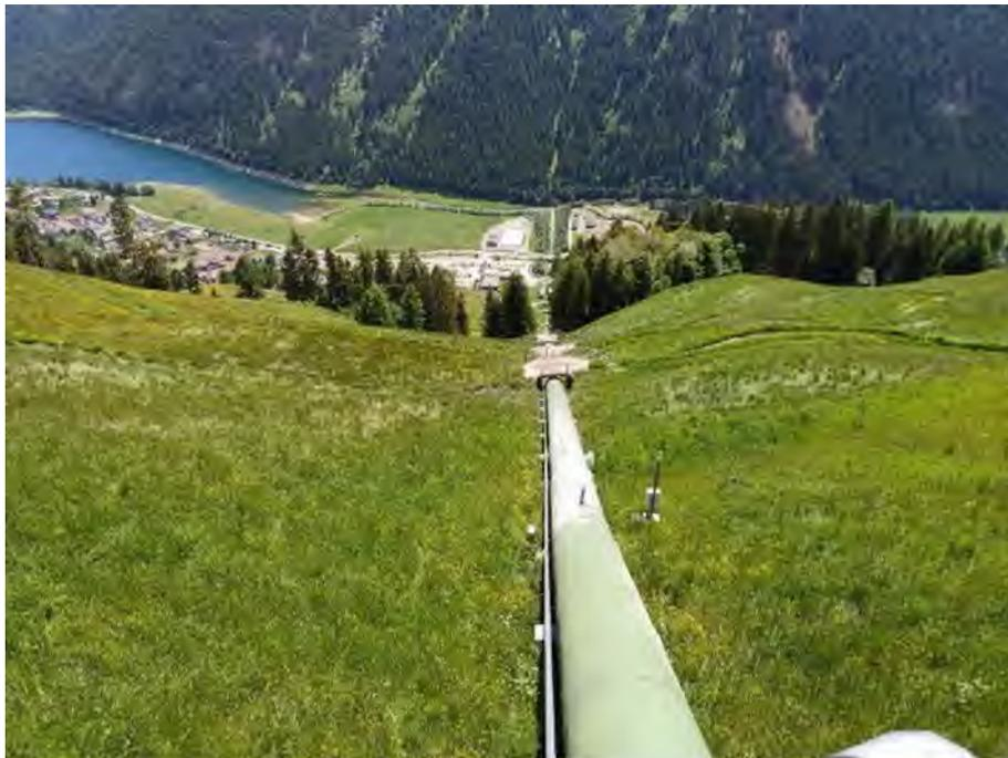
Figura 20: Tratto medio terminale della condotta visto da uno dei ponticelli prossimi al maso Tumpf. Si osservano delle ondulazioni riconducibili almeno in parte a frane superficiali del genere di quella verificatasi nel 1965
