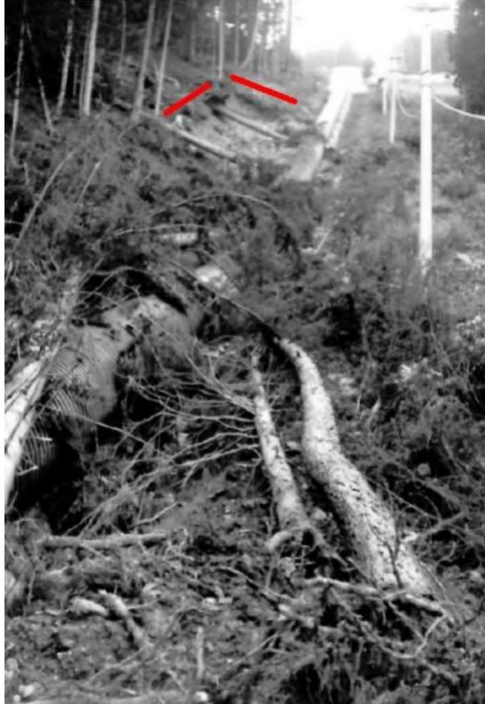
Figura 21: Frana del 2 Settembre 1965 lungo la condotta forzata che scende alla centrale di S. Valburga. Sullo sfondo, a monte, s'intravede il blocco n. 6. Le linee in rosso evidenziano il ciglio di distacco. Foto di repertorio ENEL. (ripresa dalla relazione CESI).
