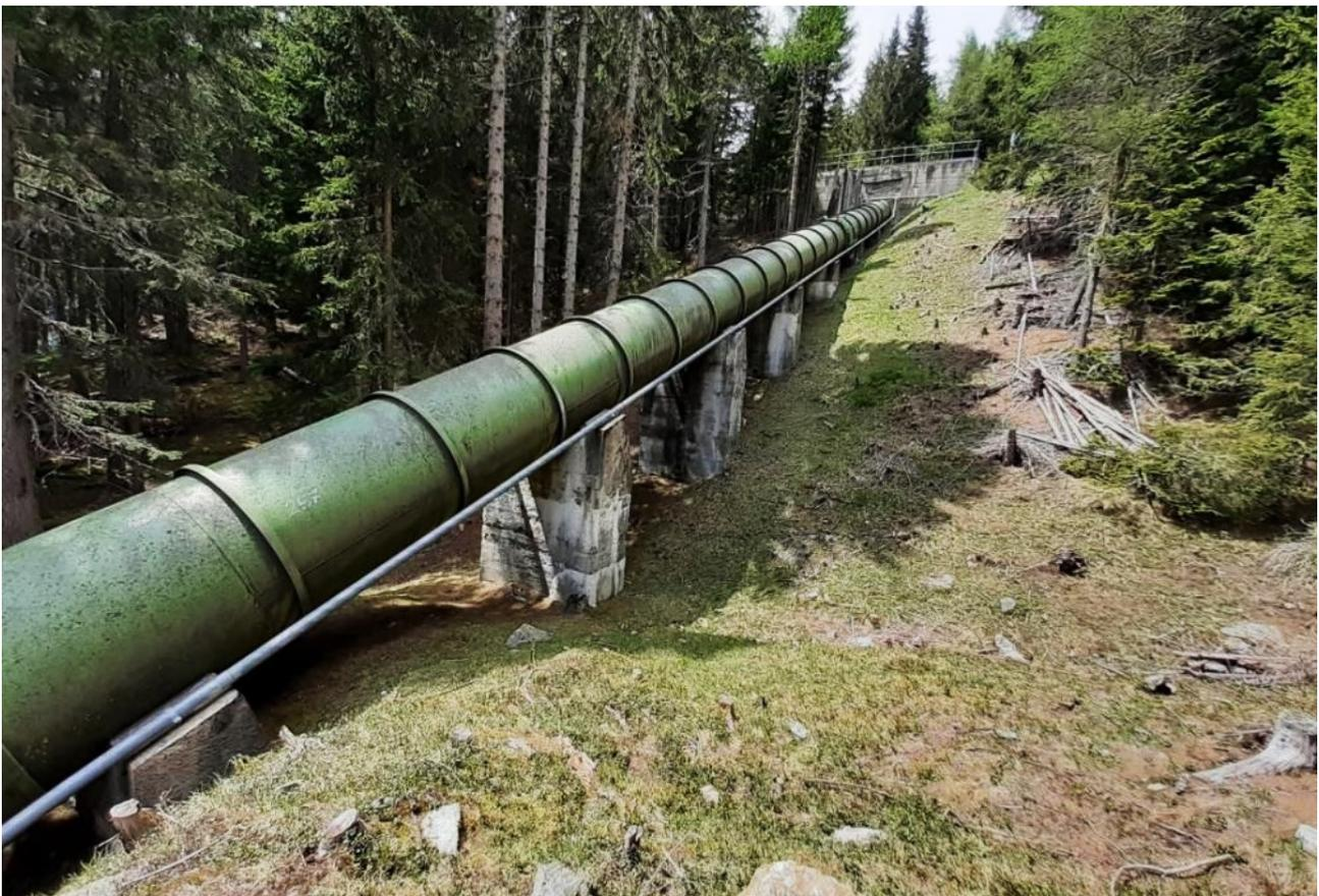
Foto 1: Vista ravvicinata di un tratto di condotta forzata da sostituire.
