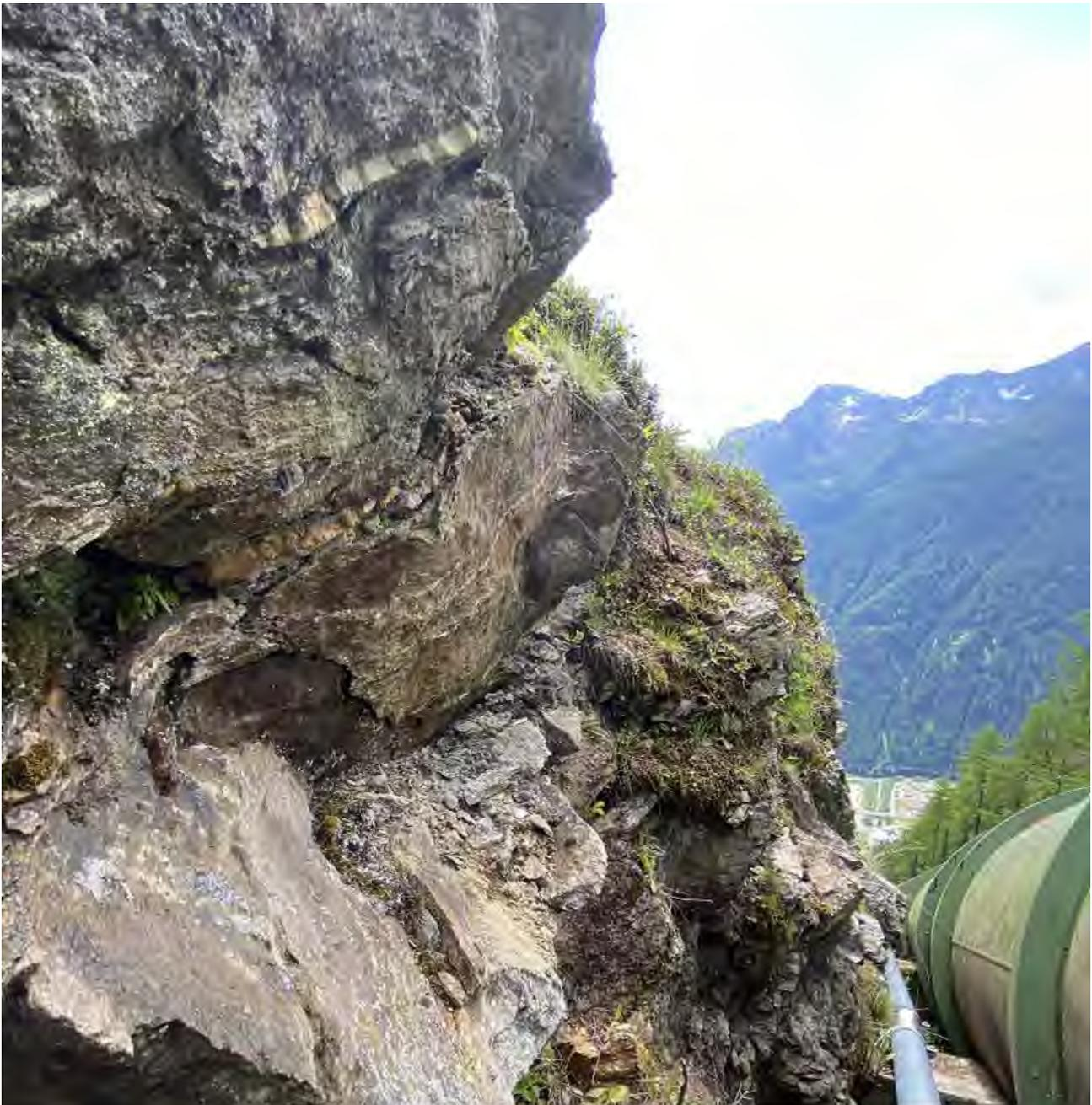
Figura 18: Affioramento di micascisti lungo la trincea in cui è stata realizzata la condotta, poco a valle della camera a valvole.
