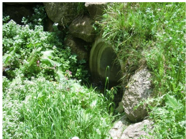
Foto 4: Verrohrung im mittleren Abschnitt der Skipistenverbindung.
