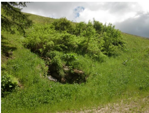
Foto 3: Hangwasseraustritt im Mittelteil der Skipistenverbindung.
