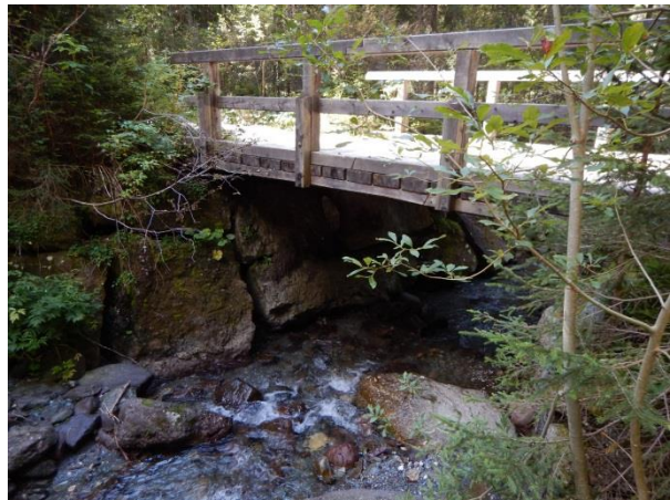
Foto 12: Bestehende Holzbrücke über den Klammbach.
