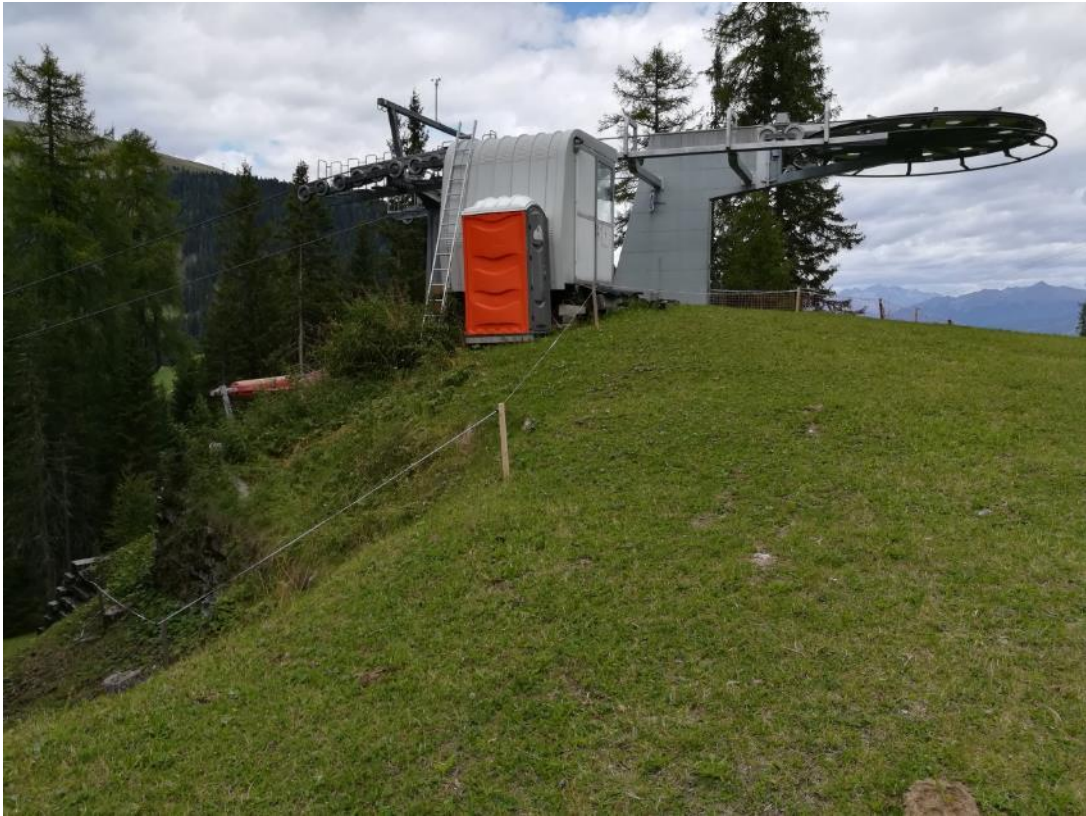
Bergstation des bestehenden Sesselliftes
