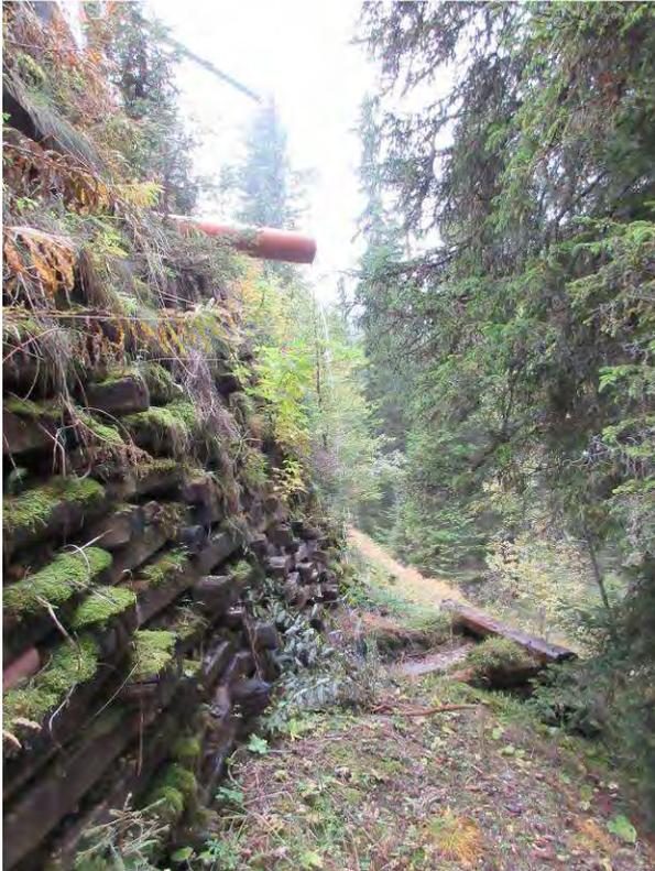
*Rohrleitung mit Wasserabfluss talseitig der Stützstruktur der Talstation*
