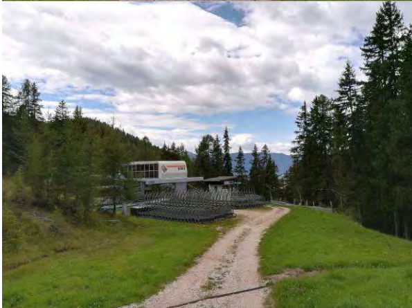
Bestehende Talstation mit seitlichem Graben
