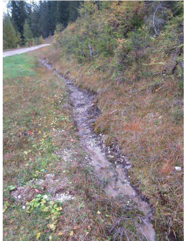
Seitlicher, wasserführender Graben entlang der bestehenden Zufahrtsstraße zur Talstation
