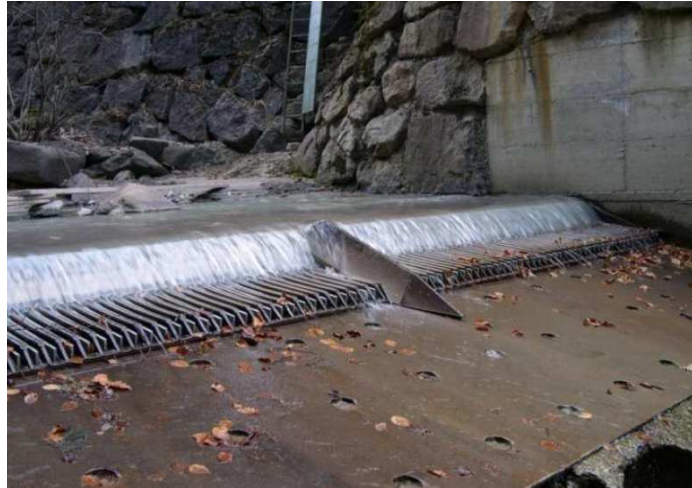
Figura 3: Einlaufbauwerk am Pescarabach Bild 3: Opera di presa sul T.te Pescara
