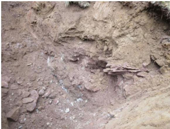
Aushub Sc4 / scavo Sc4
