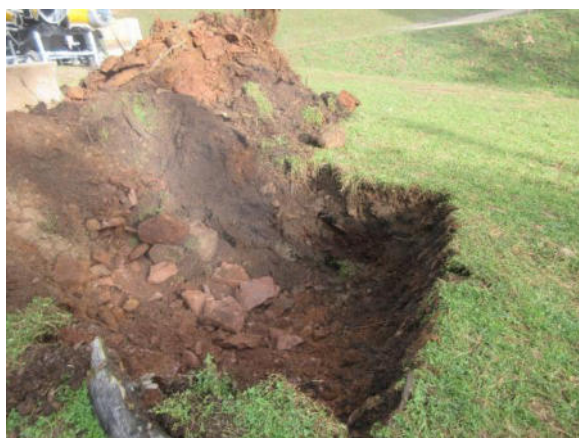
Aushub Sc2 / scavo Sc2
