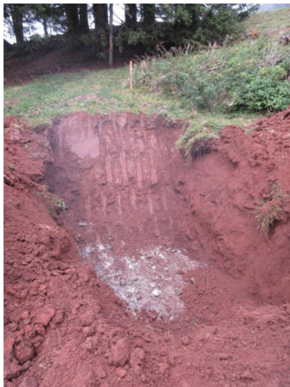
Aushub Sc3 / scavo Sc3
