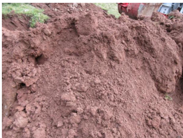
Aushub Sc3 / scavo Sc3
