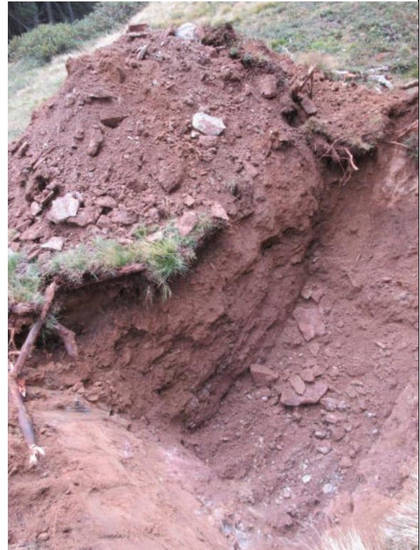
Aushub Sc4 / scavo Sc4
