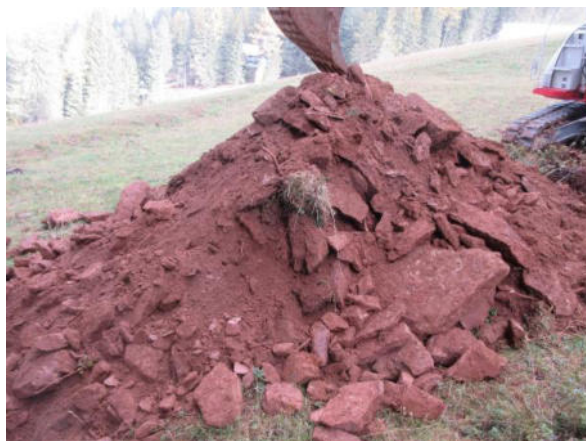
Aushubmaterial / materiale di scavo
