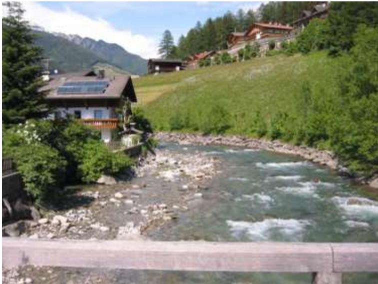
*Die vorgesehene Wasserrückgabe orographisch rechts, hinter dem im Bild ersichtlichen Haus. Die Zyklopen-Schutzmauer orographisch links (rechts im Bild) soll um ca. 1,5 m erhöht werden.*
