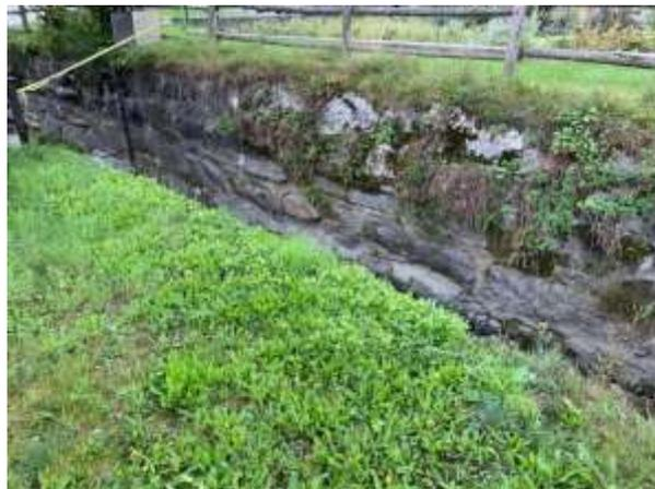
*Mörtelverfugte Mauer des Ableitungsschachtes, teilweise bewachsen*
