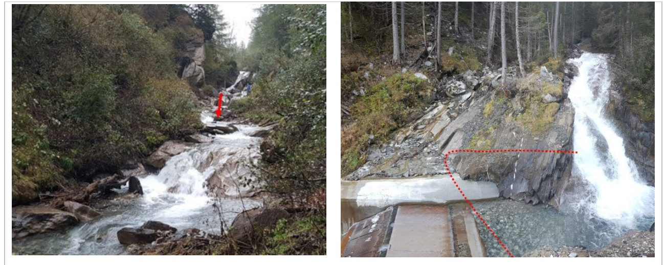
Abb. 1: Standort der geplanten Anlage, Fotos mit indikativ gekennzeichnete Fassung und Rückgabe am Oberbergbach
