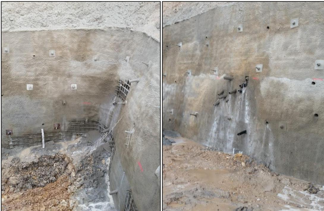
**Abbildung 6 und Abbildung 7:** Beispiele für Drainagen bei vernagelter Spritzbetonwand
