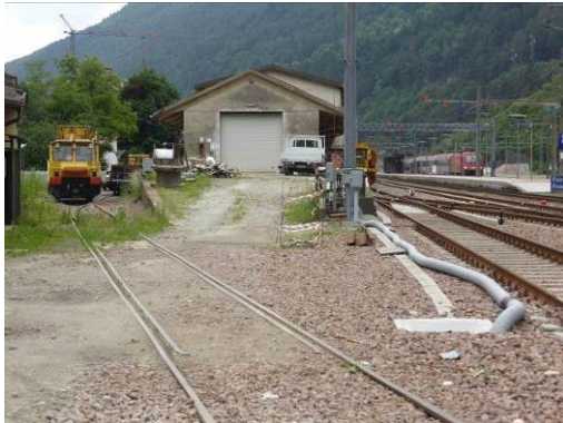
Edificio Gebäude „A5“ con rampa di accesso
