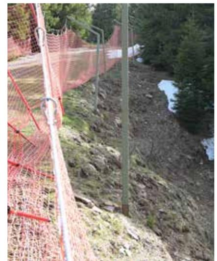
Abbildung 7: Bereich mit steiler talseitiger Böschung (Sicherung durch auslaufende Böschung - keine bewehrten Erdwälle)
