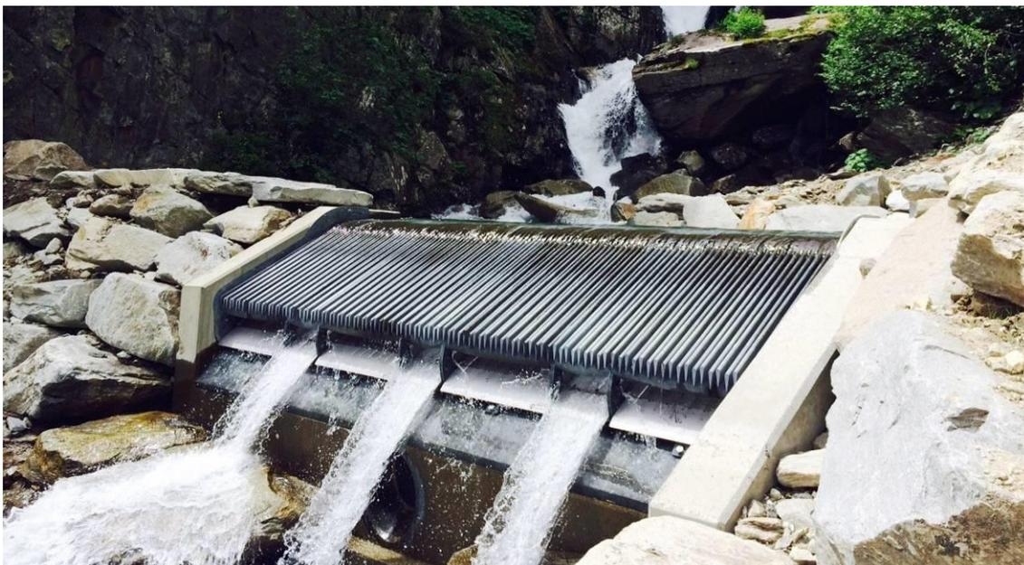
Figura 3.3 – Opera di presa tipo Coanda (fonte: Relazione tecnica di progetto)
