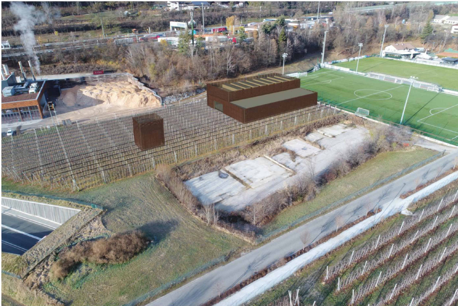
8 Rückkühler 13,15x2,65m auf Stahlgitterboden
