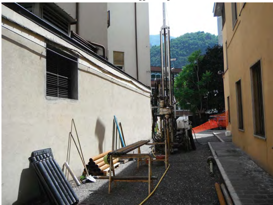
Postazione Sondaggio Geognostico
