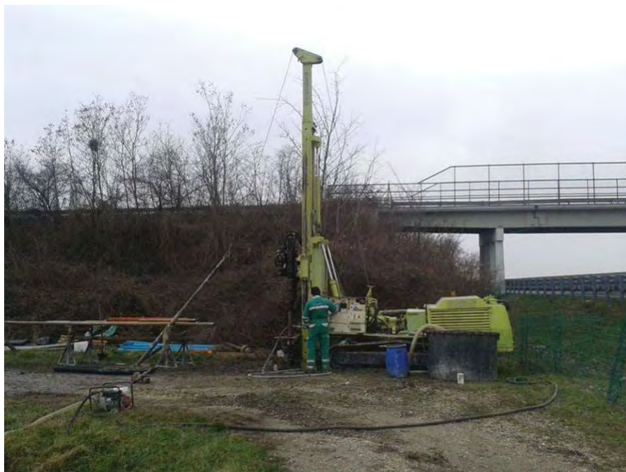
Figura 10 – Esempio di sondaggio geognostico.
