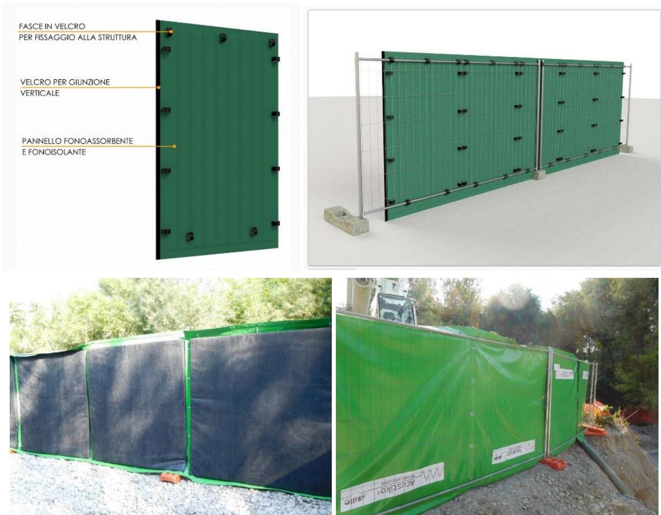
Figura 94 – Esempio di teli e pannelli per la realizzazione di barriere antirumore da cantiere, barriere antipolvere e visive
