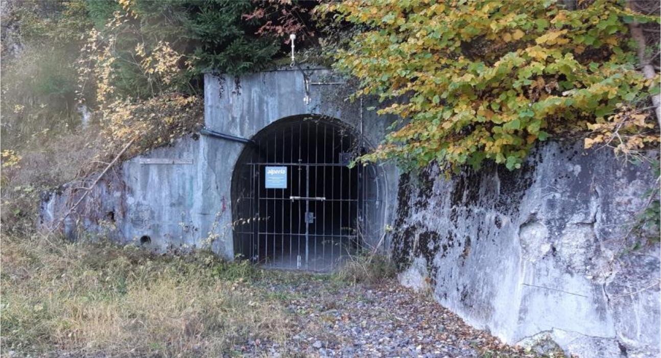
Figura 64 – Attuale accesso alla camera a valvole, da dismettere.
