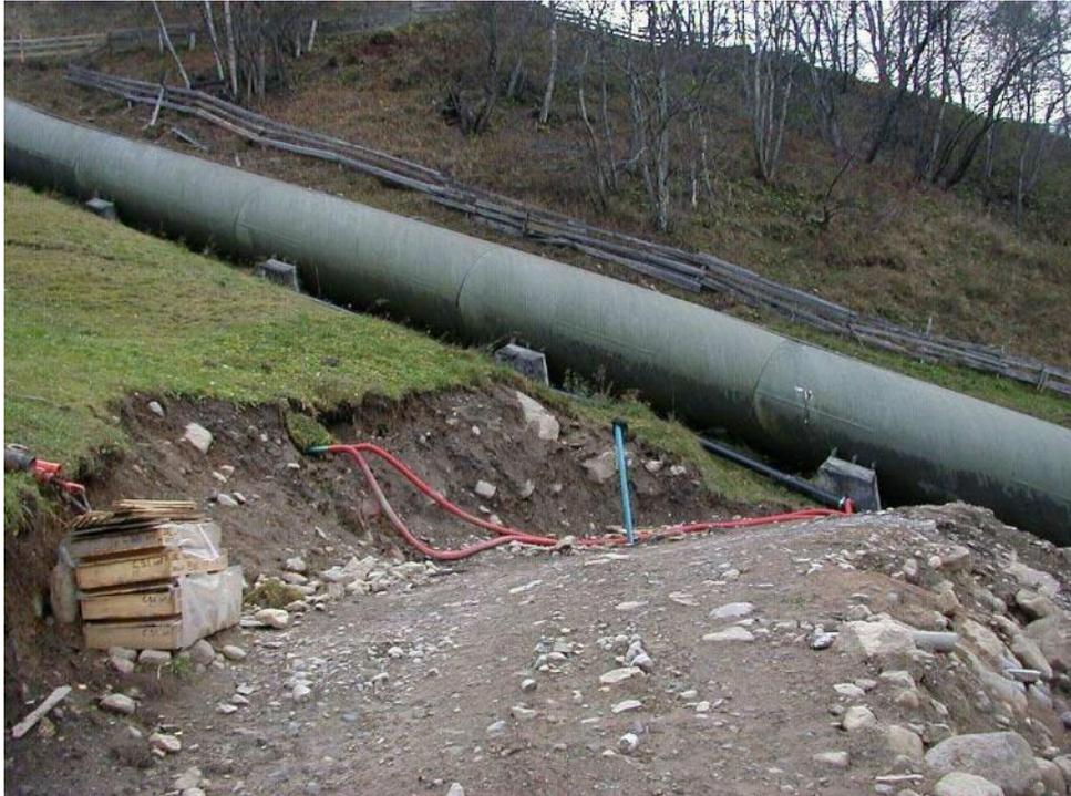
Figura 33 - Affioramento di depositi di versante, intaglio artificiale in occasione della perforazione dei drenaggi suborizzontali in ottobre 2002: ciottoli e blocchi inglobati in una matrice sabbio-limosa.
