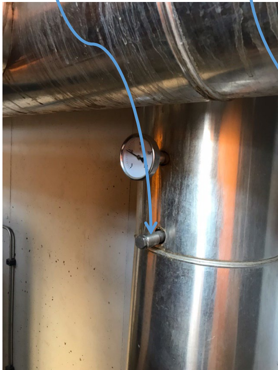
Foto dei due punti di campionamento (per ogni camino) uno esterno sul tetto ed uno interno nella zona motori
