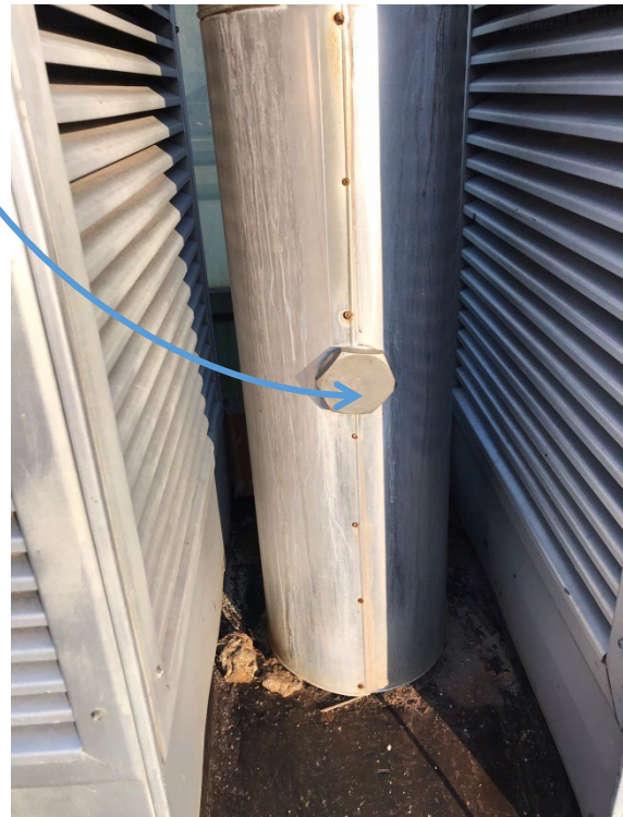
Foto dei due punti di campionamento (per ogni camino) uno esterno sul tetto ed uno interno nella zona motori
