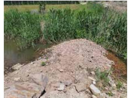
Abbildung 5: Offener Rückfluss mit Schotterfilter
