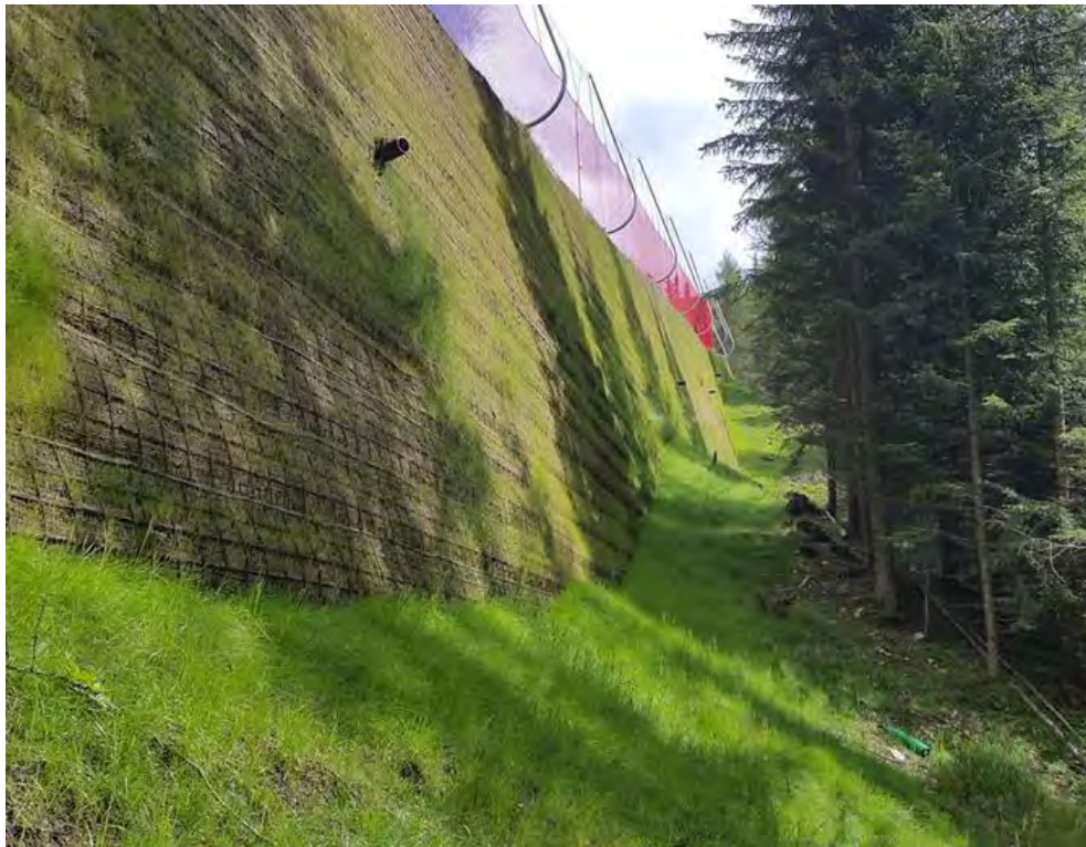
Bsp. Für hohe bewehrte Erdwälle an der Skipiste Luckner-Schwand im Skigebiet Gitschberg-Jochtal
