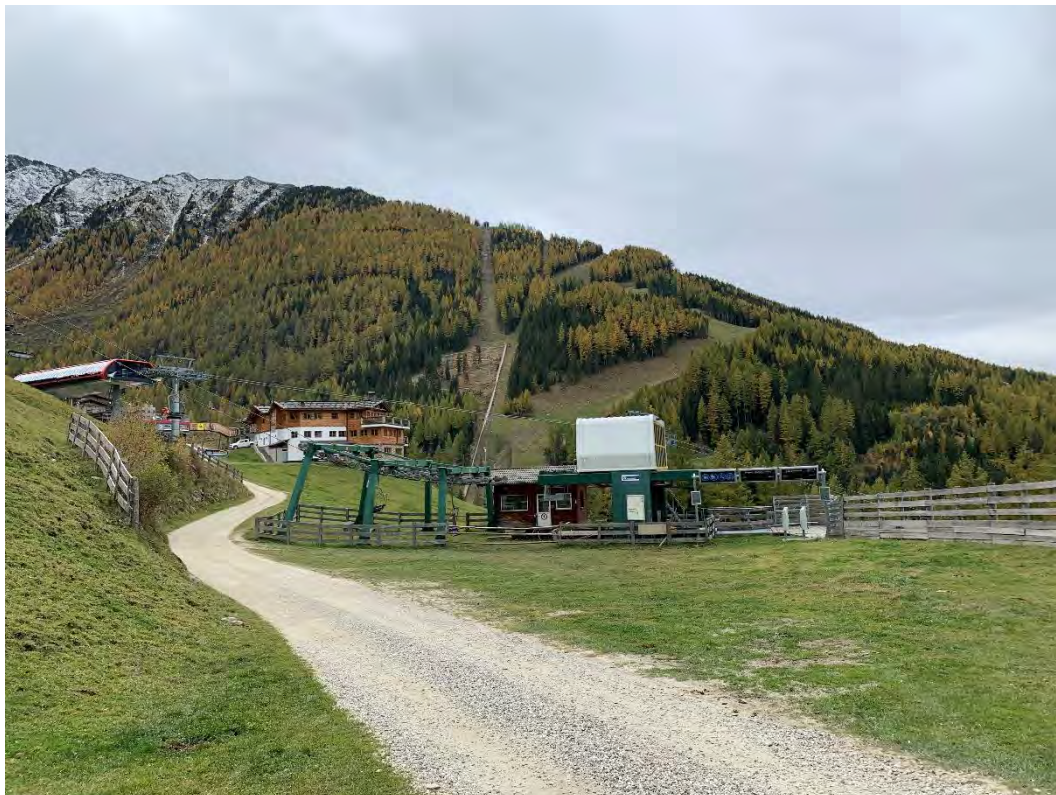
Stazione di valle dell'attuale seggiovia triposto fissa SONNENLIFT, da dismettere secondo progetto
