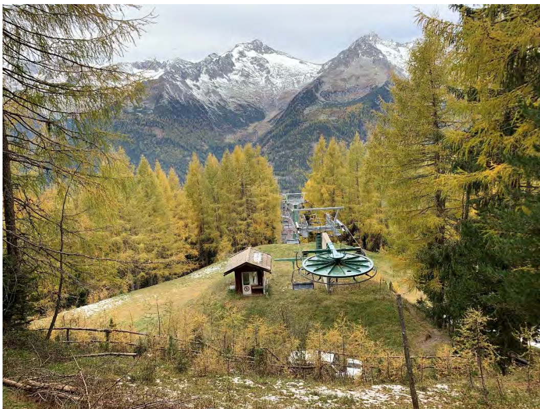
Stazione di monte dell'attuale seggiovia triposto fissa SONNENLIFT, da dismettere secondo progetto
