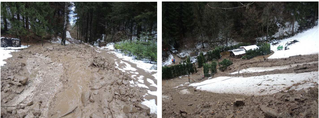
Figura 21: le foto qui sopra mostrano una colata di versante a valle della strada comunale "Gaido", ad Appiano. A causa delle forti precipitazioni dell'11.12.2017 – una combinazione di pioggia e neve bagnata – grandi quantità di acqua hanno invaso la strada, innescando così una colata di fango. Nelle due foto si può vedere l'area di accumulo della colata da versante. Un recinto di pecore, una cantina ed anche la strada podereale sono stati danneggiati.
