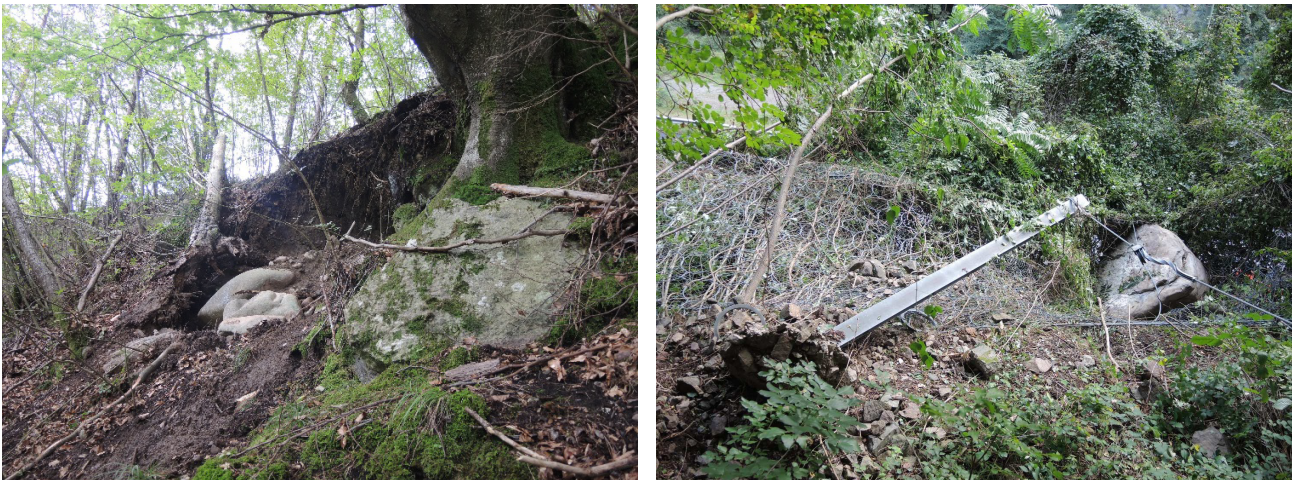
Figura 20: la foto mostra la zona di distacco del blocco, quasi 40 m a monte della strada statale di Val Sarentino. È facilmente intuibile come il blocco fosse incorporato nel terreno prima che le forti precipitazioni lo liberassero. Di seguito è crollato verso valle. Il blocco con dimensioni pari a 2 \text{ m}^3 è stato trattenuto da una rete paramassi elastica subito sopra la strada, senza la quale le conseguenze sarebbero potute essere di gran lunga peggiori
