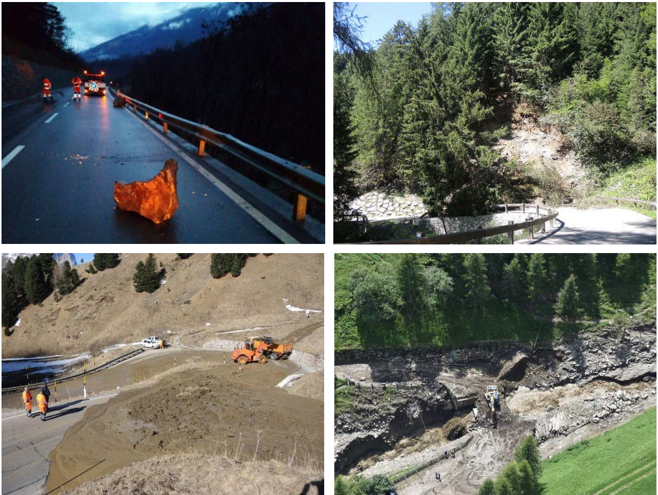
Figura 16: le foto in alto mostrano diversi tipi di frane. In alto a sinistra, l'11 dicembre 2017, si è verificato un crollo di blocchi sulla SS 38 al km 174+650 nei pressi di Laces. In alto a destra, il 13 agosto 2017, sulla strada comunale Mazzes – Flanes, nel comune di Vipiteno, si è verificato uno scivolamento. Le due foto in basso mostrano la differenza tra una colata di versante e una colata detritica: in basso a sinistra è visibile una colata di versante presso il tornante verso il Passo Gardena, avvenuta il 28 marzo 2017; in basso a destra, invece, una colata detritica nella Val di Fosse il 5 agosto 2017
