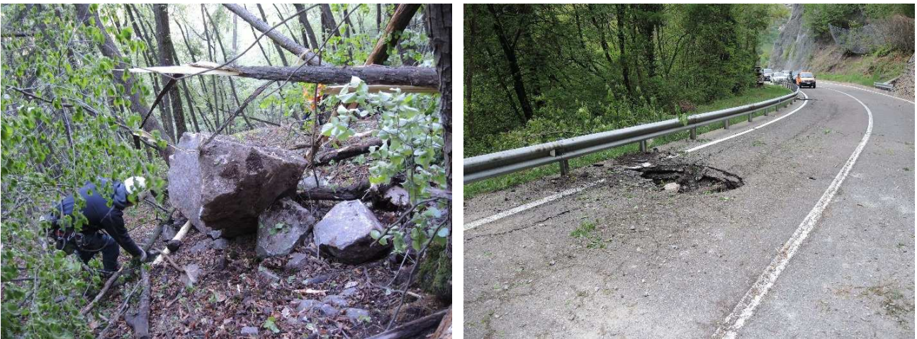
Figura 19: la foto a sinistra mostra uno dei blocchi crollati. Numerosi alberi sono stati abbattuti. La foto a destra mostra il cratere d'impatto lasciato da un blocco. Se si guarda la foto in dettaglio, si può vedere che il blocco ha saltato il guardrail dopo l'impatto sull'asfalto senza nemmeno toccarlo
