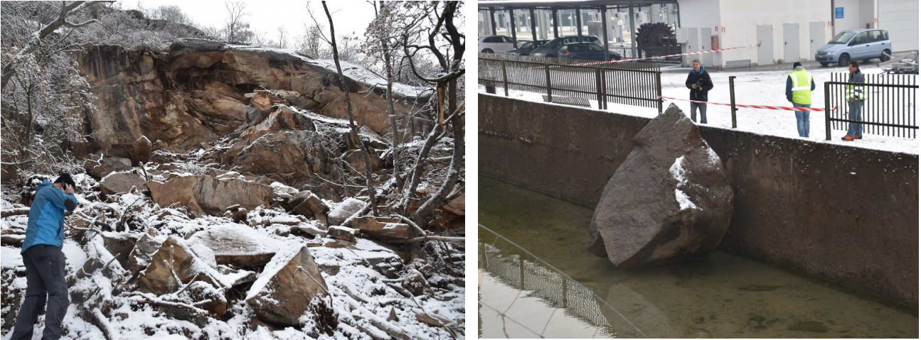
Figura 22: il 15 dicembre, poco dopo la mezzanotte, si è verificato un crollo di blocchi nella zona della centrale elettrica di Naturno e della funivia di Unterstell. Numerosi blocchi sono crollati verso valle e hanno causato notevoli danni alla stazione a valle della funivia. Il blocco più grande, di circa 8 \text{ m}^3 , è rimasto nel canale di scarico della centrale elettrica di Naturno, a circa 25 m a est della stazione a valle. I blocchi provengono da una parete di roccia costituita dagli ortogneiss di Parcines con intercalazioni di bande di paragneiss. Queste intercalazioni sono punti deboli che fungono da piani di scorrimento e riducono la resistenza della roccia. A causa delle forti precipitazioni dei giorni precedenti in combinazione con gelo e disgelo, la zona debole satura d'acqua è stata sollecitata a tal punto che circa 120 \text{ m}^3 di roccia si sono ribaltati e crollati verso valle
