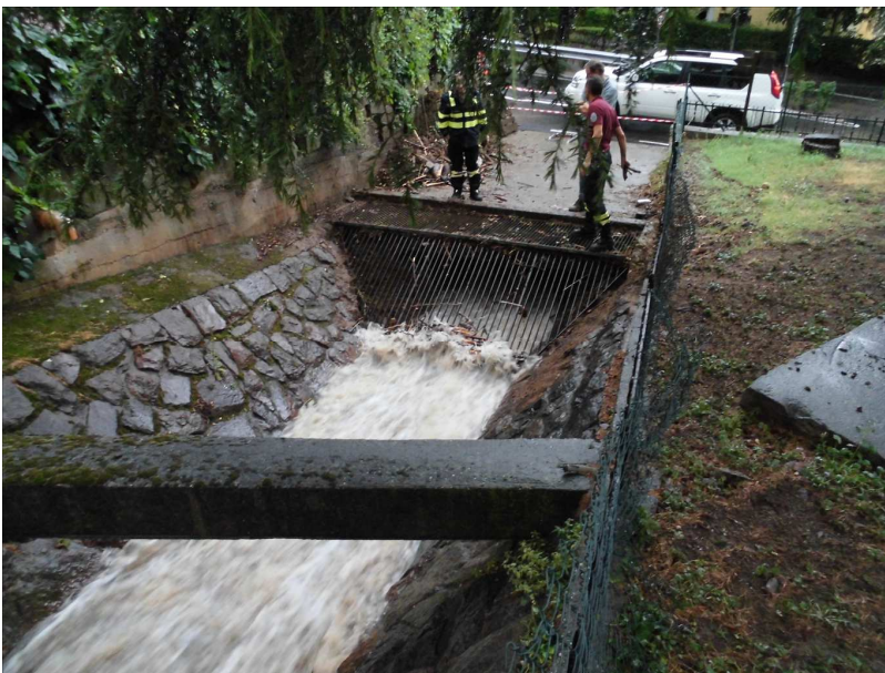
Figura 9: ai margini delle aree urbane gli impluvi, normalmente privi di portata, vengono convogliati in canalizzazioni artificiali, spesso sotterranee. In occasione di forti temporali queste strutture entrano facilmente in crisi e non sono in grado di smaltire le portate
