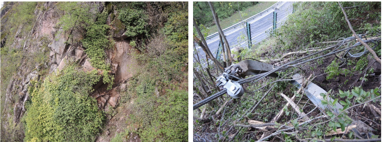
Figura 18: la foto a sinistra mostra l'elevata fessurazione dell'ignimbrite - roccia vulcanica - con alberi ed arbusti che si ancorano nelle fughe fratturando quindi sempre di più le stesse. La foto a destra è stata scattata dopo l'evento di aprile, quando le reti paramassi sono state gravemente danneggiate o in parte distrutte
