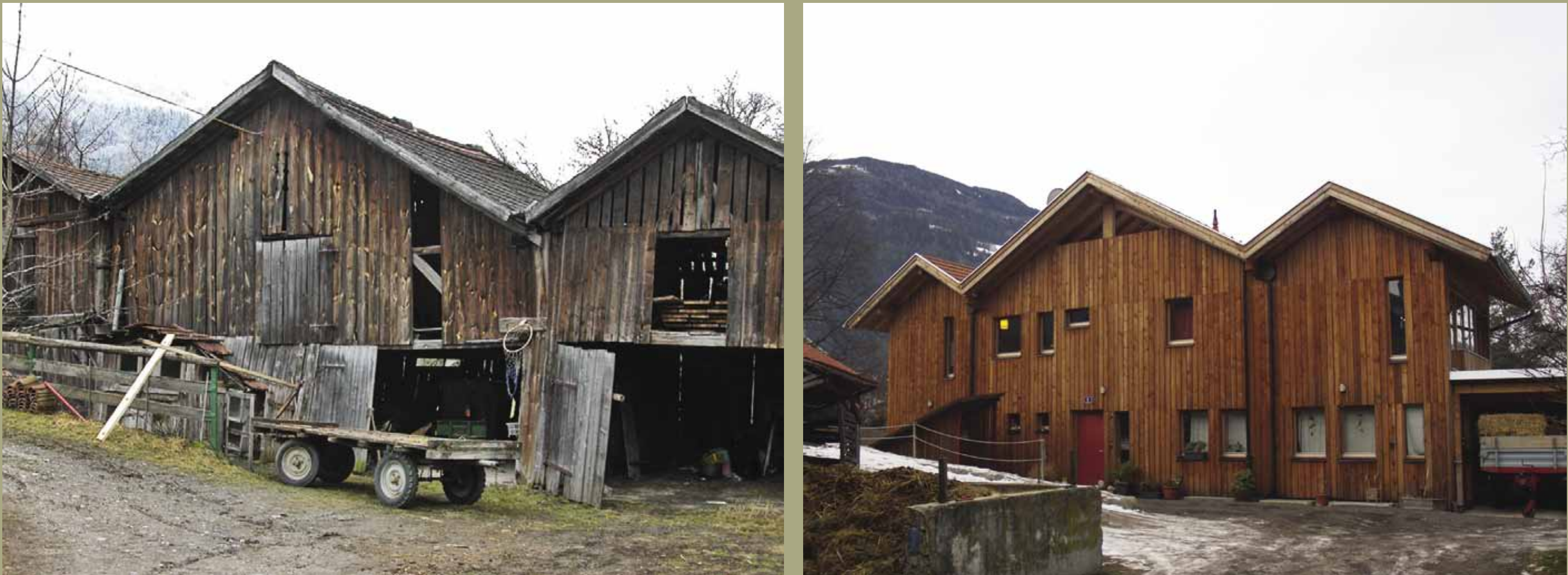
Casa Heinz-Alexander prima e dopo il risanamento generale
