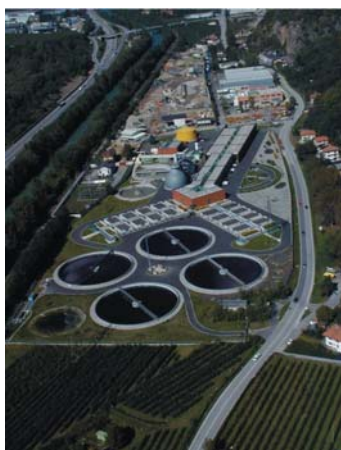
Kläranlage Meran Impianto di depurazione Merano
