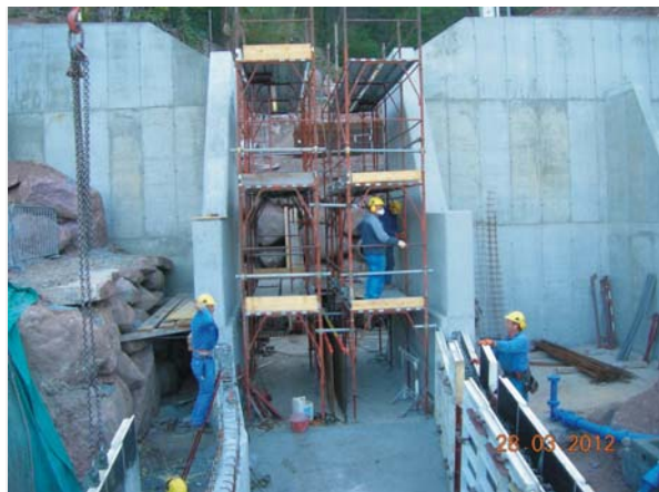
Bau einer Geschieberückhaltesperre im Widumtalgraben in Burgstall Costruzione di una briglia di trattenuta nel Fosso Widumtal a Postal
