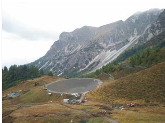
Das Beschneigungs- und Löschbecken von Ladurns in Baufase
