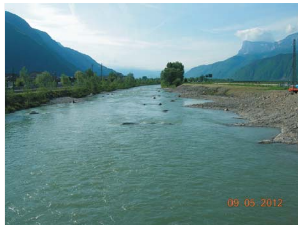
Aufweitung der Etsch bei der neuen Trambrücke in Lana/Burgstall Allargamento dell'Adige nei pressi del nuovo ponte ferrotramviario a Lana/Postal
