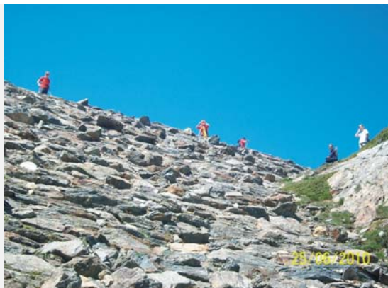
Historische Hochwasserrückhaltestauauer der Plima im Martellertal: Topografische Vermessung Diga storica per laminazione piene del Plima di Val Martello: controllo topografico
