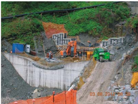
Foto: Erneuerung der Sperrenstaffelung am Geiselsbergerbach - Gemeinde Olang Risanamento di una serie di briglie sul Rio di Sorafurcia - Comune di Valdaora
