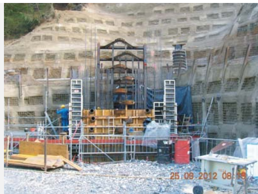
Foto: Errichtung der Seilsperre für Wildholz an der Rienza Gemeinde Bruneck
