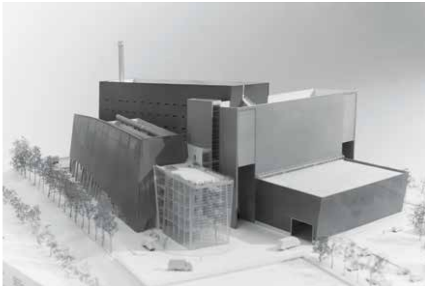
Thermische Müllverwertungsanlage Impianto di termovalorizzazione Waste-to-energy plant
