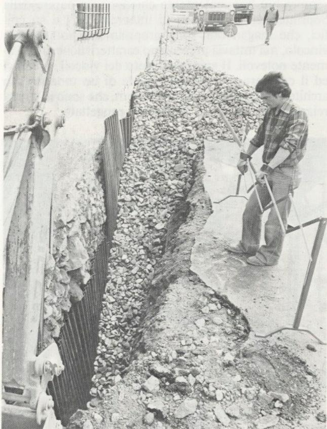
*Entfeuchtungsmaßnahmen an den Außenmauern von Schloß Velturns. In der Regel genügt es, daß ein Graben bis zur Unterkante der Fundamente ausgehoben wird, der alte Verputz durch einen Kalkmörtel – nicht Zement – ersetzt, ein Drainagenrohr eingesetzt und der Graben mit großem Schotter aufgefüllt wird.*
