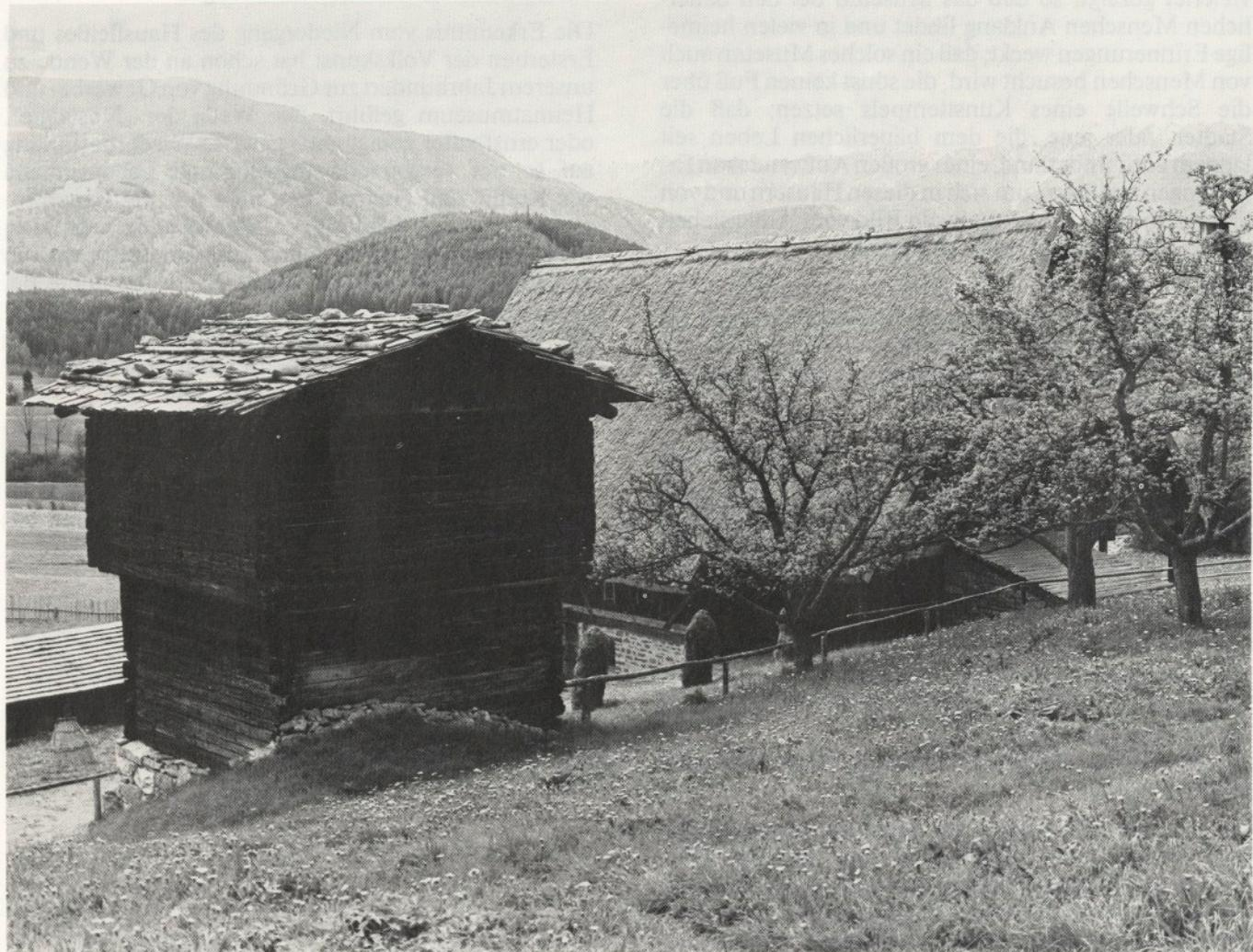
10. Mühle aus St. Peter in Ahrn. Zweigeteilter Raum, zwei unterschlächtige Wasserräder, eines für die Mühle, eines für die Gersterändl. Die Rändl diente ebenso wie ein Stampf zum Enthülsen von Gerste und von Leinsamen.
