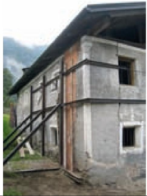
Auf diese Weise konnte das einsturzgefährdete Nordwest-Eck mit seinem aufgezputzten Eckpilaster gerettet werden; lediglich ein schmaler Abschnitt der besonders stark ausbauchenden Nordfassade musste abgetragen und neu aufgemauert werden. Die Arbeiten werden im nächsten Jahr fortgeführt. ka
