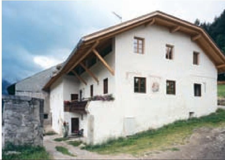
Holzkonstruktion nochmals erneuert und mit einer Reihe von Schlepplagen versehen. Das Dach wurde mit Lärchenschindeln neu eingedeckt. *ka*
