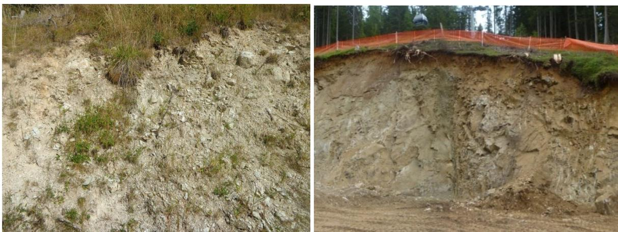
**Abb. 4** Links: Stark aufgelockerter und verwitterter Granit oberhalb der Almen „Gampen“; Rechts: Aushub an der Talstation Gaisjochbahn (Sommer 2011) in verwittertem bzw. stark zerlegtem Granit, im unteren Aushubabschnitt ist das ursprüngliche Felsgefüge großteils noch erhalten.
