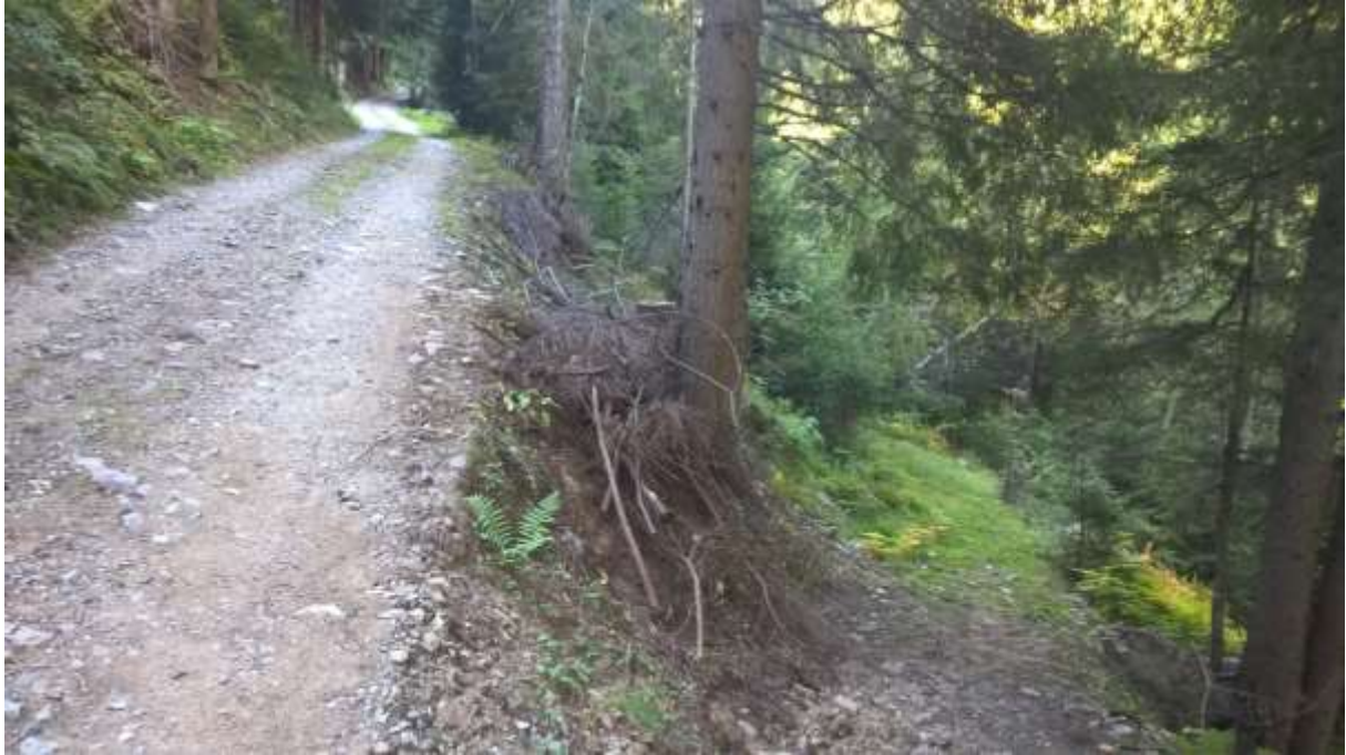
Almweg mit voraussichtlicher Druckleitungstrasse rechts
