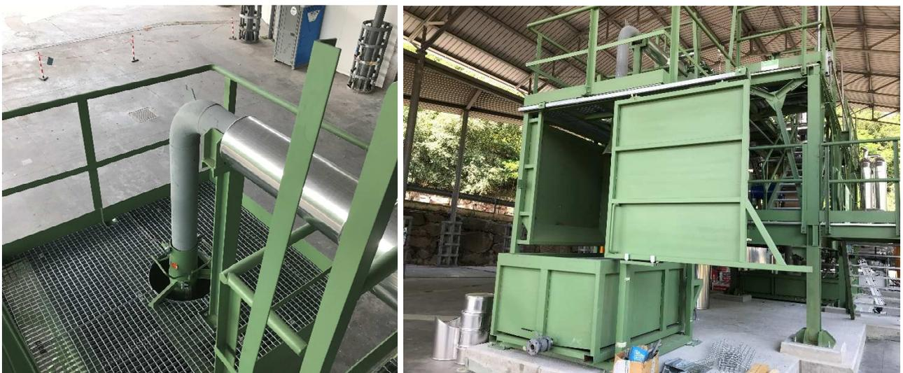
Figura 5. Tubazione scarico e sistema di raccolta: struttura porta filtro a sacconi e vasca raccolta eluato.
