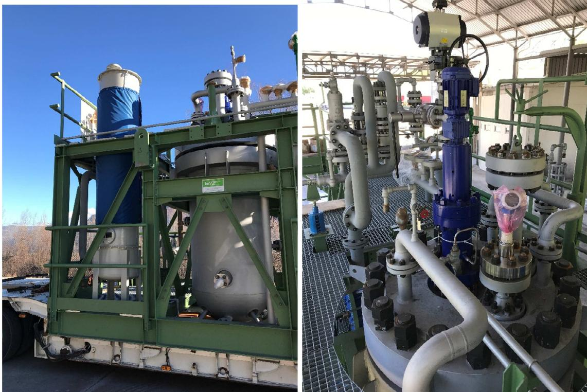
Figura 2. Reattore incamiciato, dispositivi di sicurezza, agitatore e strumentazione varia.
