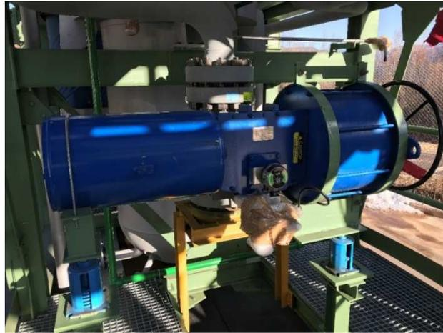
Figura 4. Valvola intercettazione per scarico reattore.
