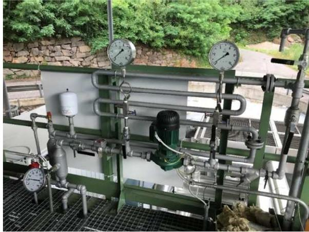
Figura 3. Sistema di raffreddamento agitatore.
