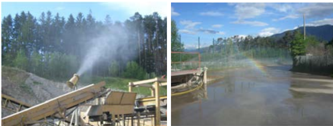
Abbildung 11: Wasserspritzkanone gegen Staubentwicklung und Zufahrtsstraße
