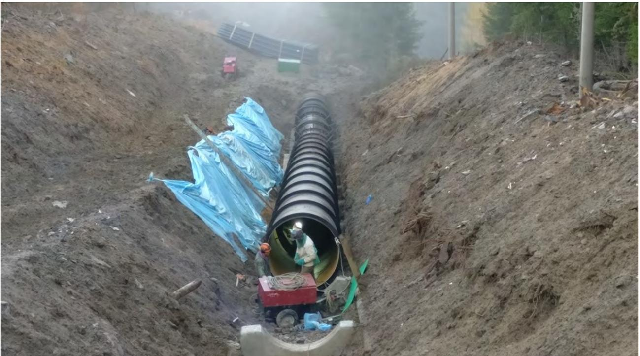
**Figura 30 – Fase 3: posa della nuova condotta e risistemazione del terreno per la copertura completa.**
