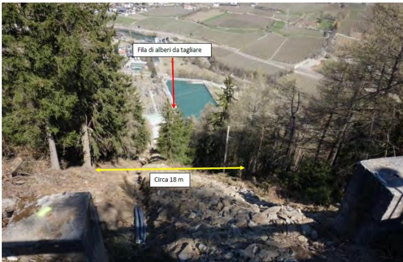
**Figura 31 –** Indicazione della fascia libera necessaria per i lavori di sostituzione della condotta nel tratto di bosco inferiore (vista da monte verso valle).
