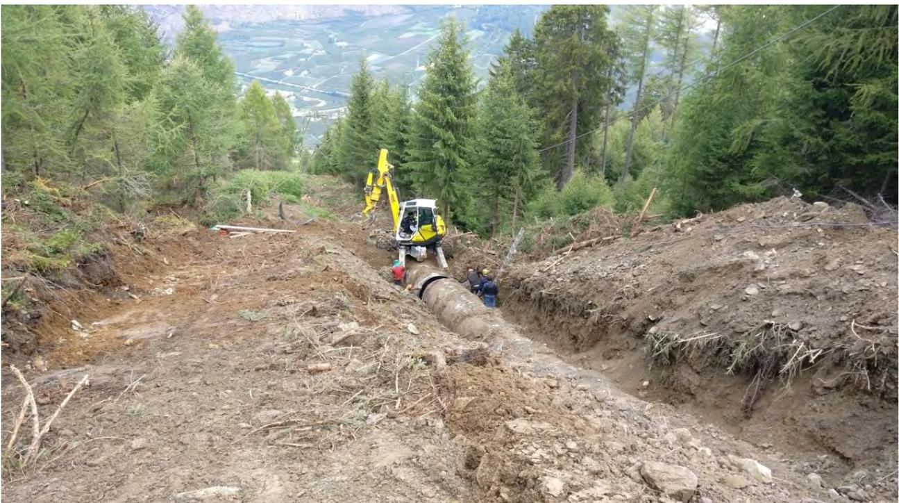
**Figura 28 – Fase 1: esbosco, creazione di pista di servizio sul lato occidentale, scavo con “ragno per rimozione della vecchia tubazione.**
