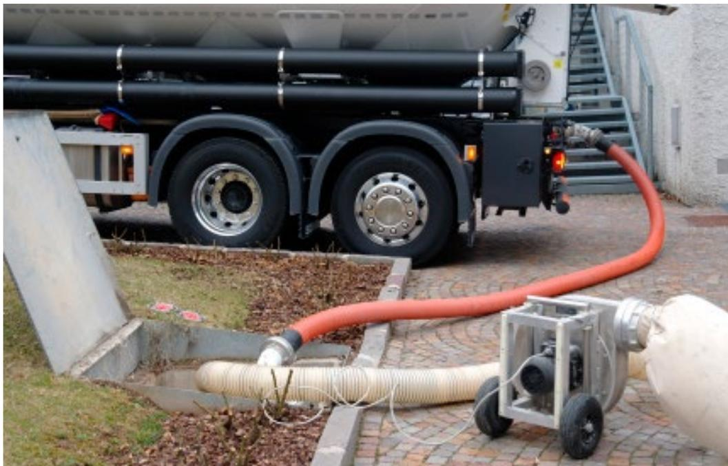
Foto der Befüllung eines Erdlagers durch einen zertifizierten Tankwagen. Im Vordergrund das Sauggebläse für die Luftabsaugung.
