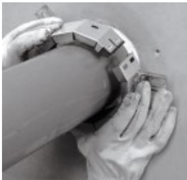
Manschetten für Rohre aus brennbaren Material
