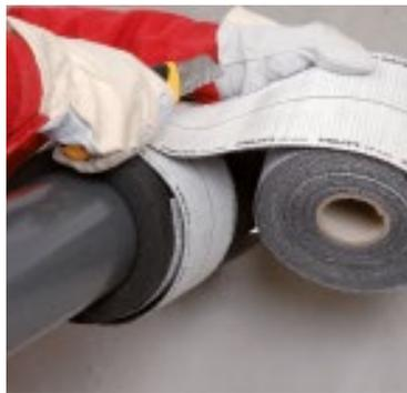
Manschetten für Rohre aus nicht brennbarem Material
