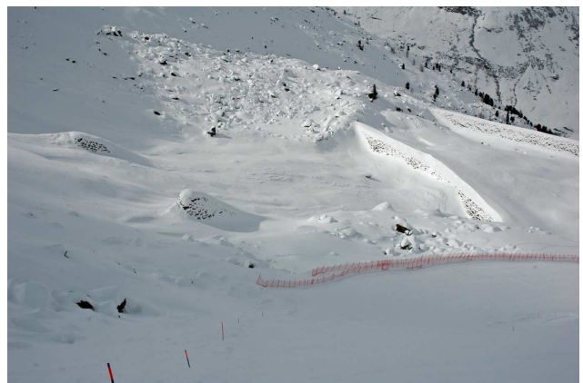
Abbildung 25: links, die Anbruchzone der Karjochlawine 05.03.2017; rechts: von der Karjochlawine überflossene Lawinenbremskegel und zwei 10m hohe Lawinenauffangdämme (Gem. Moos i.Passeier)
