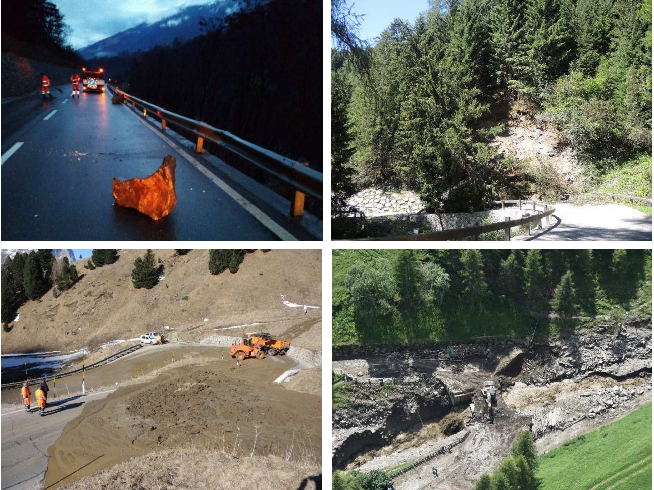
Abbildung 16: Die Fotos zeigen verschiedene Arten von Massenbewegungen. Links oben ein Blockschlag auf der SS 38 km 174+650 bei Latsch, der sich am 11. Dezember 2017 ereignet hat. Rechts oben sieht man eine Rutschung am 13. August 2017 auf der Gemeindestraße Matzes – Flans, in der Gemeinde Sterzing. Die beiden unteren Fotos verdeutlichen den Unterschied zwischen einer Hangmure und einem Murgang. Links unten sieht man eine Hangmure im Bereich der Kehre zum Grödnerjoch, die sich am 28. März 2017 ereignet hat. Rechts unten hingegen ein Murgang im Pfossental am 05. August 2017
