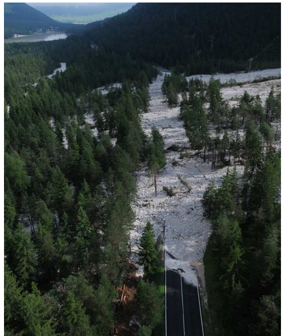
Abbildung 15: am 5. August wurde die SS 51 Alemagna durch einen Murgang über eine Länge von ca. 300 m verschüttet, mit bis zu 5 m mächtigen Ablagerungen. Bedenkt man das Verkehrsaufkommen im Sommer auf dieser wichtigen Verkehrsachse kann man nur den glücklichen Umständen danken, dass keine vorbeifahrenden Fahrzeuge betroffen worden sind
