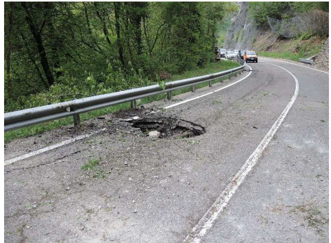
Abbildung 19: links oben einer der Sturzblöcke. Zahlreiche Bäume wurden zerschlagen. Das rechte Foto zeigt hingegen den Einschlagkrater, den ein Sturzblock hinterlassen hat. Wenn man das Foto genau betrachtet, sieht man, dass der Block nach dem Einschlag im Asphalt über die Leitplanke gesprungen ist, ohne diese auch nur zu berühren
