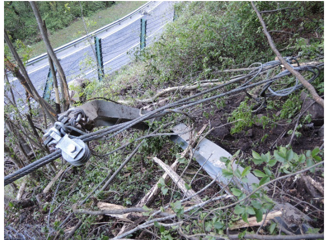
Abbildung 18: das linke Foto zeigt die intensive Klüftung der Ignimbrite – vulkanische Gesteine – mit Bäumen und Sträuchern, die sich in den Fugen verankern und so den Felsverband zunehmend auflockern. Das rechte Foto wurde nach dem Sturzereignis aufgenommen. Die Steinschlagschutzzäune wurden stark beschädigt bis teilweise zerstört
