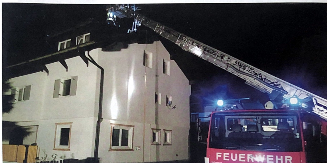
Der Dachstuhl brennt: Alarm um 2.30 Uhr
