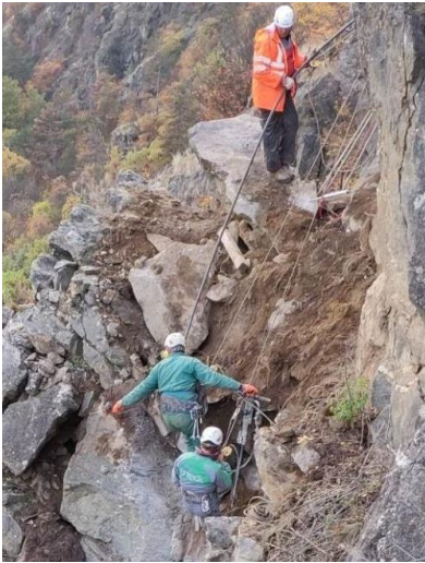
Abbildung 17: Arbeiten zur Verlegung des Sprengstoffes (links) mit Echtzeitmonitoring der Bewegungen (oben).
