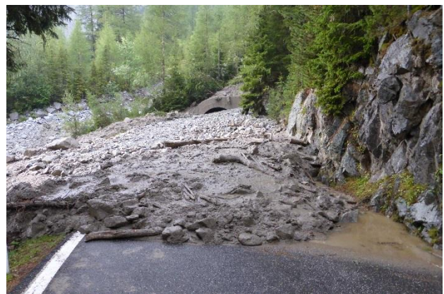
Abbildung 8: Der durch einen Murgang verschüttete Zugang zur Galerie an der Straße zum Staller Sattel.
