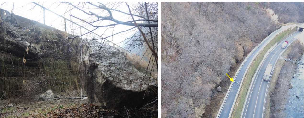
Abbildung 13. Die beiden Fotos zeigen den Einschlagbereich am Steinschlagsschutzdamm (links) mit Schäden am Asphalt des Radweges (rechts, gelber Pfeil).
