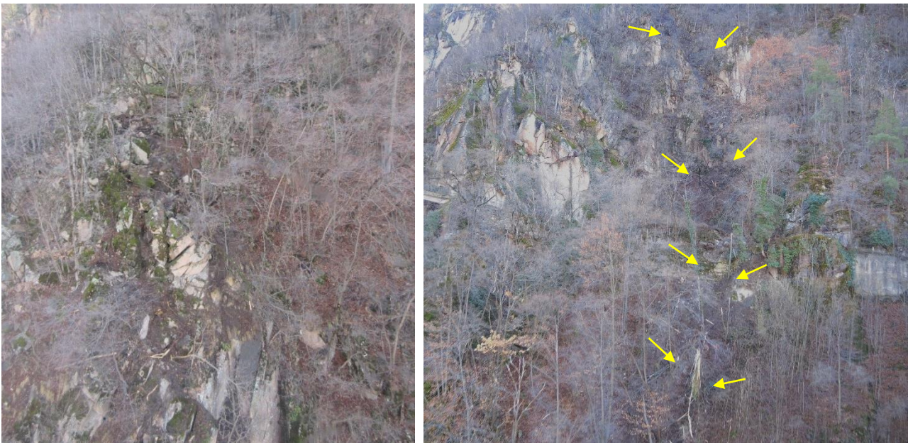
Abbildung 12. Abbruchbereich (links) und Sturzbahn (rechts) des ca. 5 m 3 großen Blockes.
