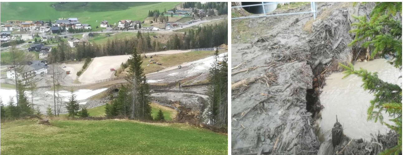
Abbildung 4: die Reaktivierung einer Rutschung unterhalb des Piz Sorega hat einen Murgang ausgelöst. Bergseitig des Parkplatzes ist der Bachlauf verrohrt (Foto rechts): Unvermeidlich daher die Verklausung und die darauf folgende Ausuferung, die Schäden in den Untergeschoßen eines Hotels und eines Wohngebäudes verursacht hat.
