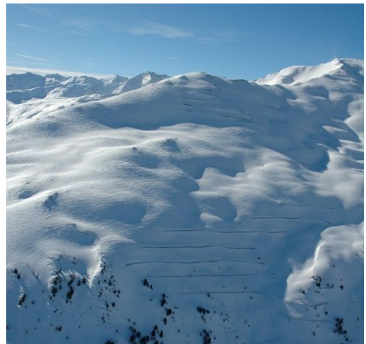
Abbildung 20: Eingeschnitte Lawinenverbauung im Skigebiet Heider Alm.
