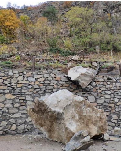
Abbildung 18: Sturzblöcke nach erfolgreicher Sprengung (links) sowie letzte Felsberäumungsarbeiten an der nun sauberen Abbruchnische kurz vor der Wiedereröffnung der Staatsstraße (rechts).
