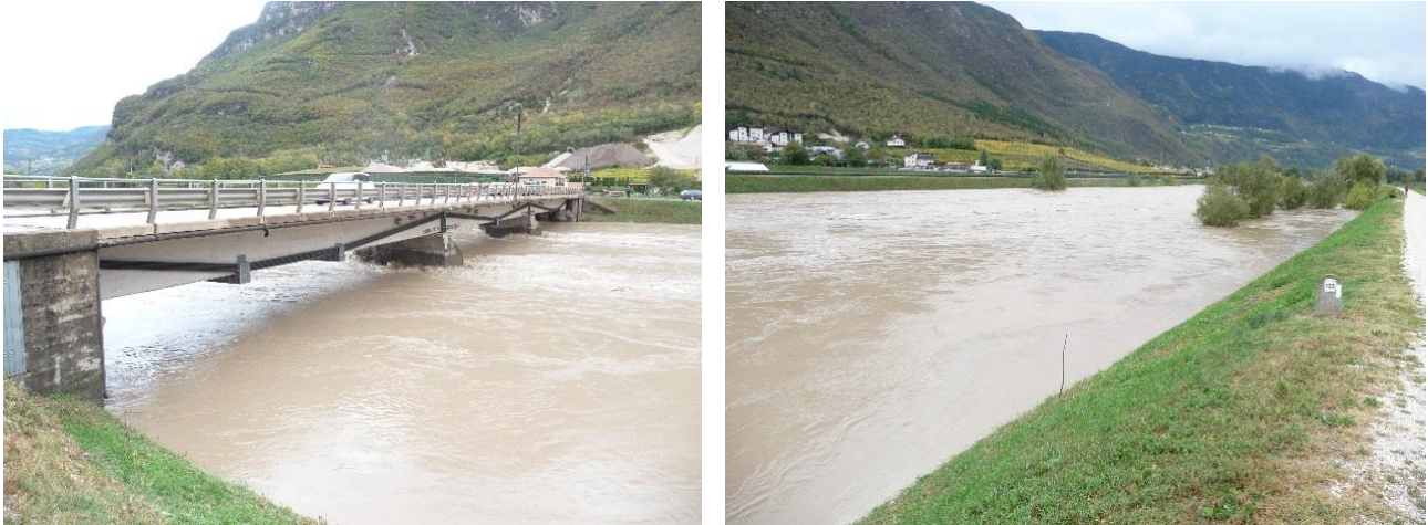
Abbildung 40: Situation an der Brücke von St. Florian (Fluss-km 122) am 30. Oktober um 8:10 Uhr.
