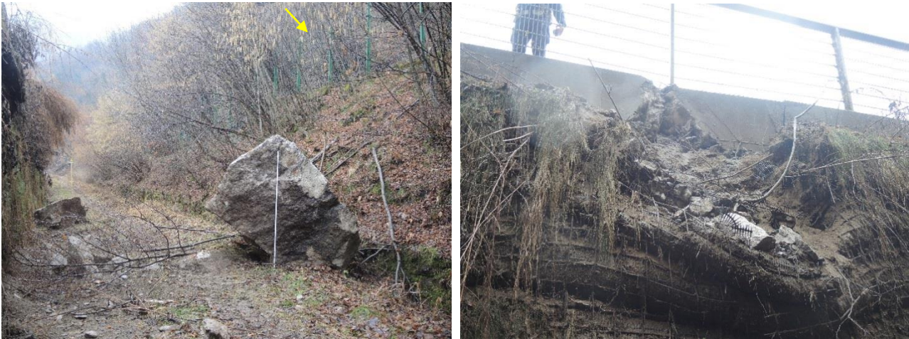
Abbildung 14. Sturzblock und übersprungener Steinschlagzaun bergseitig des Dammes (links) sowie Aufprall und Eindringtiefe am Steinschlagschuttdamm (rechts).
