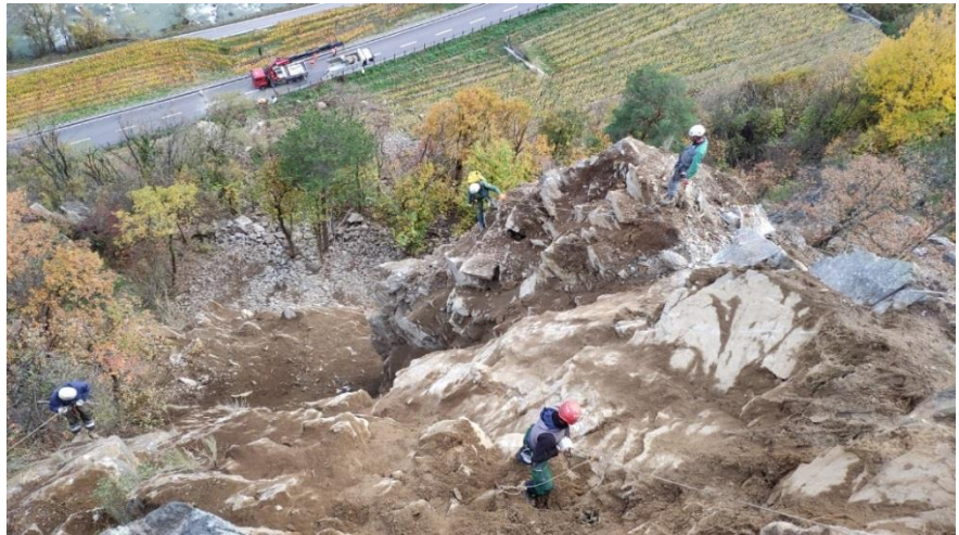
Abbildung 18: Sturzblöcke nach erfolgreicher Sprengung (links) sowie letzte Felsberäumungsarbeiten an der nun sauberen Abbruchnische kurz vor der Wiedereröffnung der Staatsstraße (rechts).
