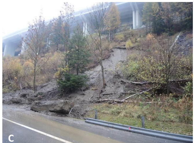
Abbildung 43: verschiedene Hangmuren, verursacht durch die Unwetterfront „Vaia“: Hangmure im Bereich des Laurin-Parkplatzes, Gemeinde Welschnofen (a); Hangmure mit Schäden an einem Wohngebäude in Quair/Großfeld, Schluderns (b); Verlegte Brennerstaatsstraße SS.12 bei km 515+000, Gemeinde Brenner (c); Hangmure entlang einer Wiese bei Sciüz, Corvara (d).
