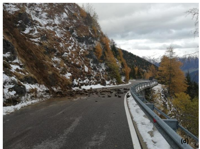
Abbildung 41: verschiedene Stein- und Blockschlagereignisse, verursacht durch die Unwetterfront „Vaia“: Windwurf und Blockschlag entlang der LS.79 bei km 0+900, Gemeinde Radein (a); Blockschlag auf das Betriebsgelände der Firma Dr. Schär in Winkelau – Burgstall (b); Windwurf und Blockschlag auf die SS.620 bei km 3+750, Gemeinde Deutschnofen (c); Steinschlag auf die SS.508 bei km 53+100 auf der Penserjoch-Straße.
