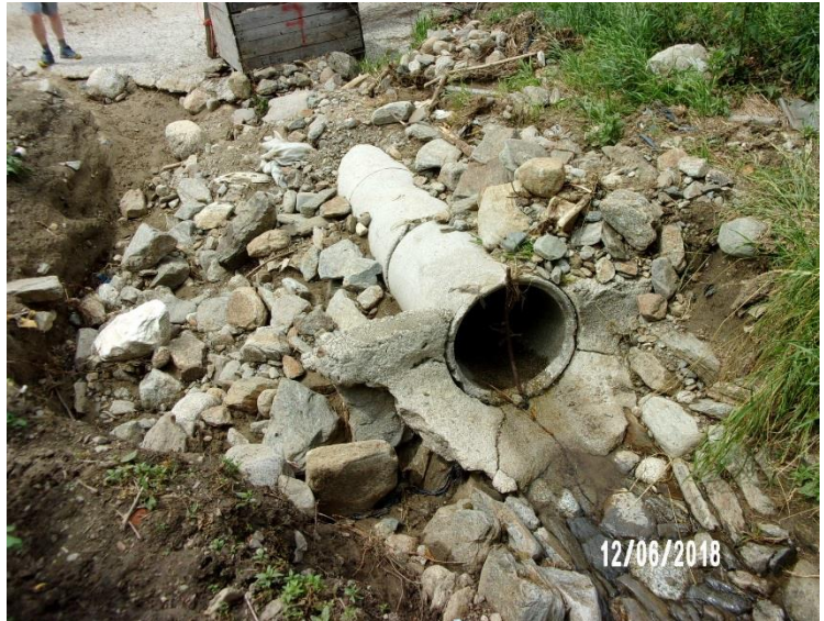
Abbildung 5: links erkennt man die typische Situation eines urbanen Abflusssnetzes, in das auch die Hangwässer eingeleitet werden; rechts die Reste einer Leitung, die einen kleinen Bach quert.
