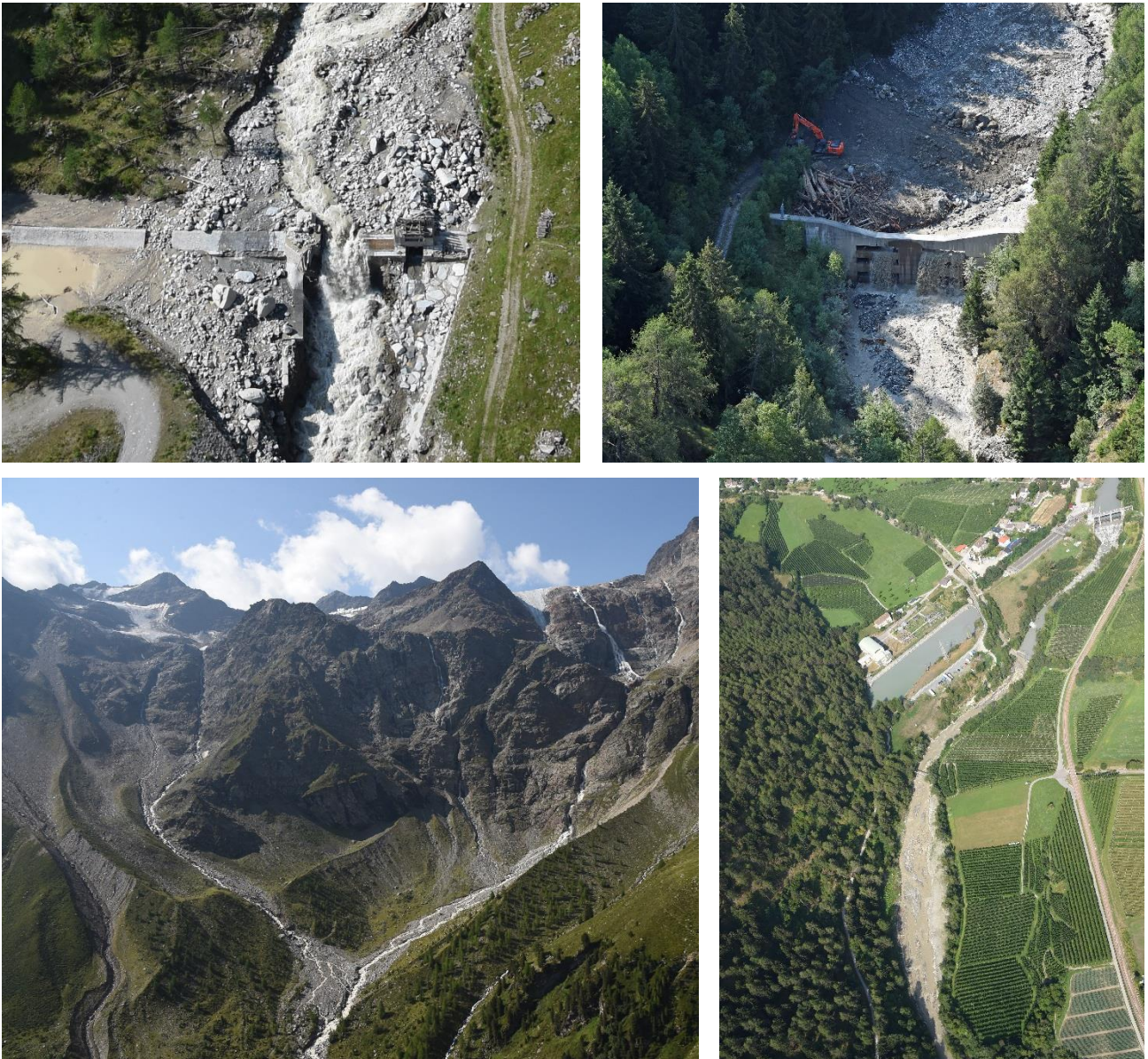
Figura 9: il trasporto solido può provocare gravi danni, come ad esempio alle opere di derivazione (foto in alto a sx). I tempestivi interventi di sgombero operati dagli Uffici di sistemazione dei bacini montani mantengono le opere efficienti. Nella foto a sinistra in basso sono evidenti i segni del progressivo ritiro dei ghiacciai alla testata del bacino del Rio di Lasa: il sedimento trasportato si riversa poi nell'Adige (foto in basso a dx).
