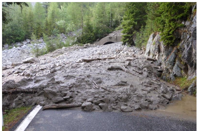
Figura 8: l'accesso alla galleria sulla strada del passo Stalle invaso dalla colata.
