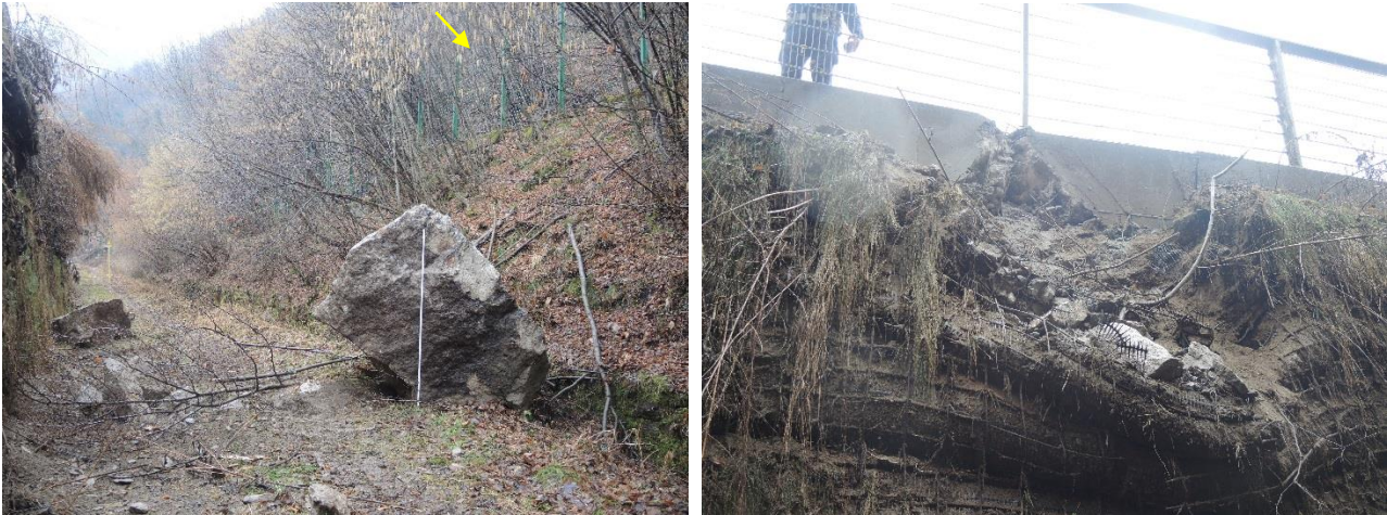
Figura 14. Blocco crollato e rete paramassi saltata a monte del vallo paramassi (a sinistra) e impatto nel vallo paramassi (a destra).
