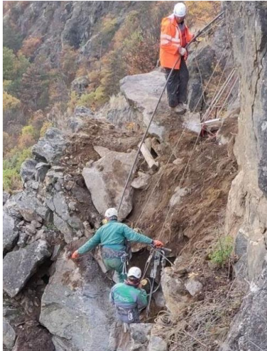
Figura 17: Lavori di posa degli esplosivi (a sinistra) con monitoraggio in tempo reale dei movimenti (in alto).
