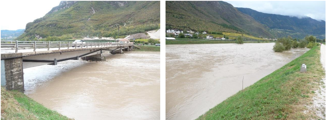
Figura 40: situazione al Ponte di San Floriano (km 122) il 30 ottobre alle ore 8:10.
