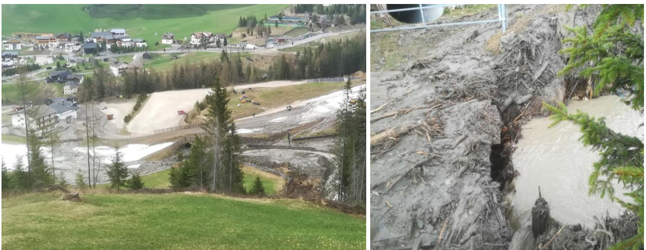
Figura 4: la riattivazione di una frana sotto il Piz Sorega ha generato una colata detritica. A monte del parcheggio l’alveo viene intubato (foto a dx): inevitabile pertanto l’occlusione e la conseguente esondazione, che ha provocato danni nei piani interrati di un albergo e di un’abitazione.
