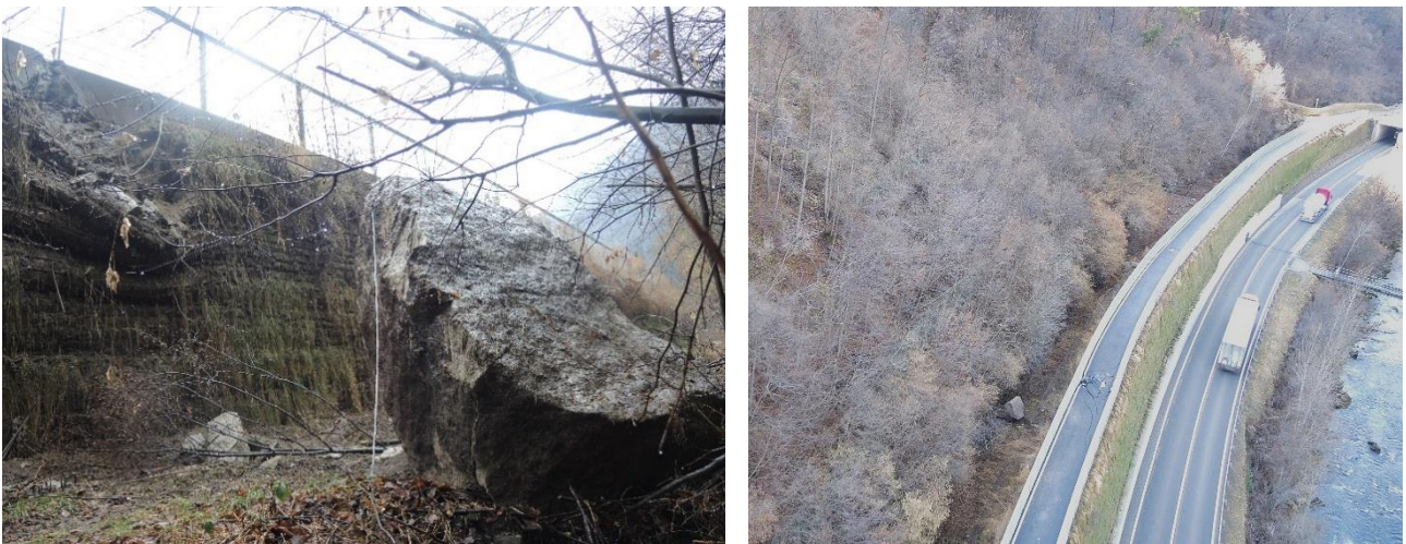
Figura 13. Le due foto mostrano l'impatto sul vallo paramassi (a sinistra) e i danni all'asfalto della ciclabile (a destra, freccia gialla).
