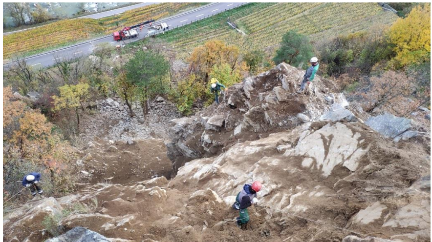
Figura 18: Caduta massi dopo il brillamento (a sinistra) e lavori finali di disaggio della parete presso la zona di distacco, ora pulita, poco prima della riapertura della strada statale (a destra).
