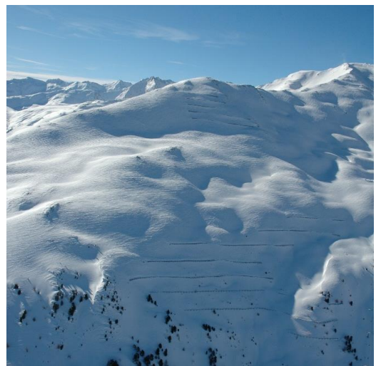
Figura 20: opere paravalanghe cariche di neve nel comprensorio di San Valentino.
