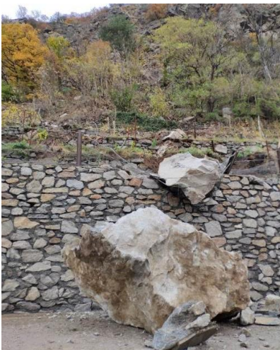
Figura 18: Caduta massi dopo il brillamento (a sinistra) e lavori finali di disaggio della parete presso la zona di distacco, ora pulita, poco prima della riapertura della strada statale (a destra).
