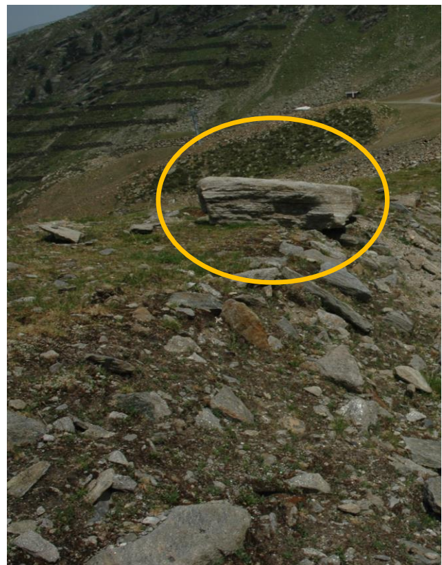
Abbildung 41: Die Obere Böden Lawine im Skigebiet Pfelders überfährt beide Lawinenauffangdämme (links). Ein über 1500kg schwerer Zyklostein wurde beim obersten Lawinenauffangdamm von der Zyklosteinmauer auf die Dammkrone befördert (rechts)
