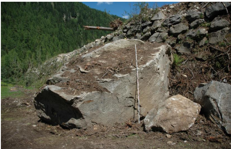
Abbildung 32: Ein rund 100 t schwerer Felsblock wurde von der Staublawine 100m weit gegen den untersten Lawinenauffangdamm befördert. Die oberste Reihe Zyklopensteine wurde aus der Verankerung gerissen (links)
