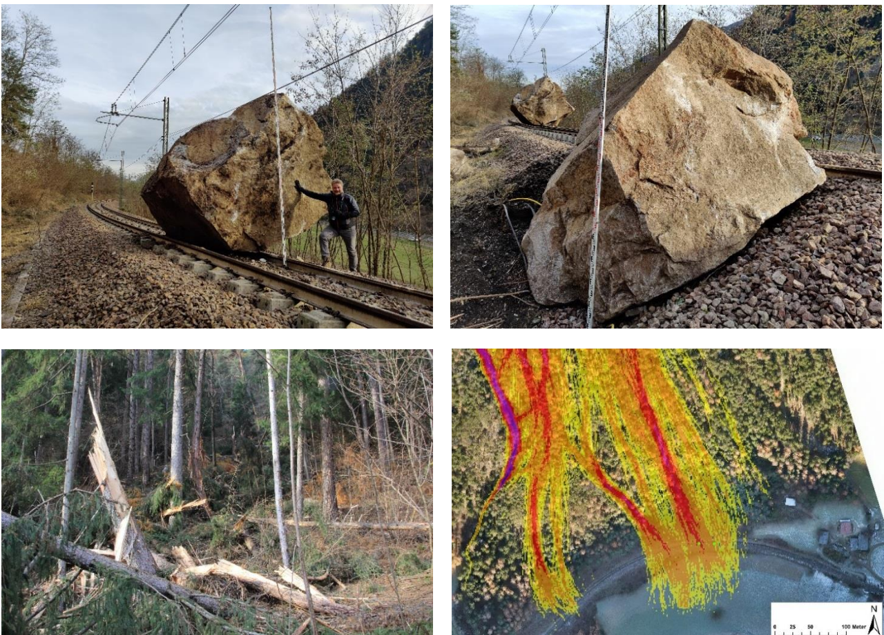
Abbildung 18: Links und rechts oben: die zwei Sturzblöcke, welche auf die Eisenbahntrasse zum Liegen gekommen sind. Im unteren linken Bild: zerschlagene Bäume entlang der Sturzbahn sowie Ergebnisse der Steinschlagsimulationen, aufgrund derer die Position, Form und Höhe der Steinschlagschutzdämme definiert wurden. Man beachte die zwei grünen Punkte, welche die Position der Sturzblöcke anzeigen. Die Simulationsergebnisse decken sich sehr gut mit der Realität, zumal sie ebenfalls eine hohe Wahrscheinlichkeit der Reichweite (rote Farben) in diesem Bereich anzeigen
