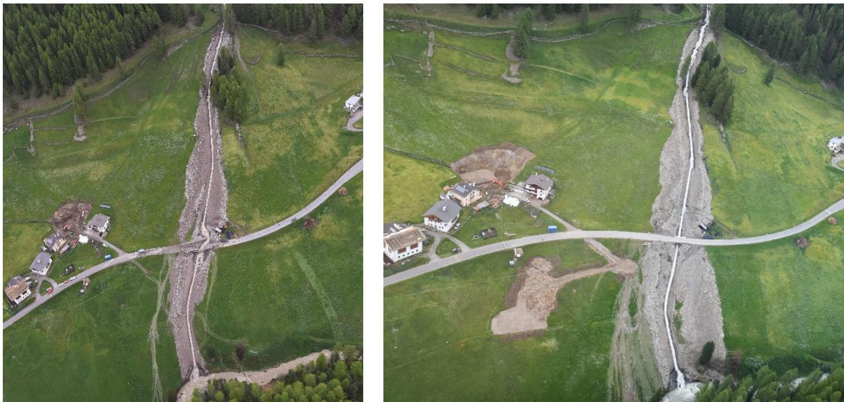
Abbildung 6: Bei beiden Ereignissen drang das Material bis an die Landesstraße von Langtaufers (links), welche bereits 2018 aufgrund mehrerer Ereignisse unterbrochen worden war (rechts)
