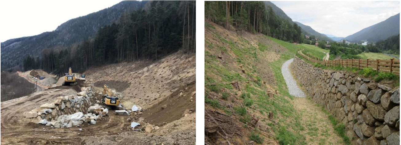
Abbildung 19: Im linken Foto sieht man den Bau des östlichen Steinschlagschutzdammes Anfang März 2020 (links im Foto die Pustertaler Bahnlinie), während das rechte Foto das fertiggestellte Bauwerk zeigt (Aufnahme Sommer 2020)
