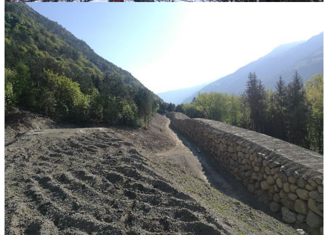
Abbildung 20: Links die Abbruchnische und die Sturzbahn des Felssturzereignisses. Rechts einer der Sturzblöcke sowie der fertiggestellte Steinschlagschutzdamm bergseitig der Vinschgauer Staatsstraße
