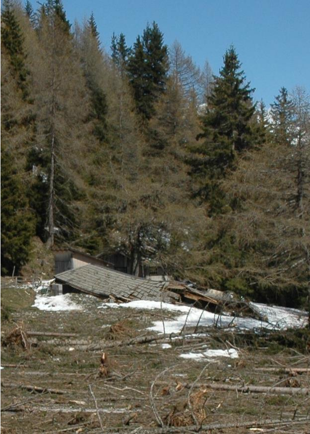
Abbildung 27: Von der Grubberglawine zerstörte Jssenhütte. Vom Luftdruck beschädigte Grubberghütte
