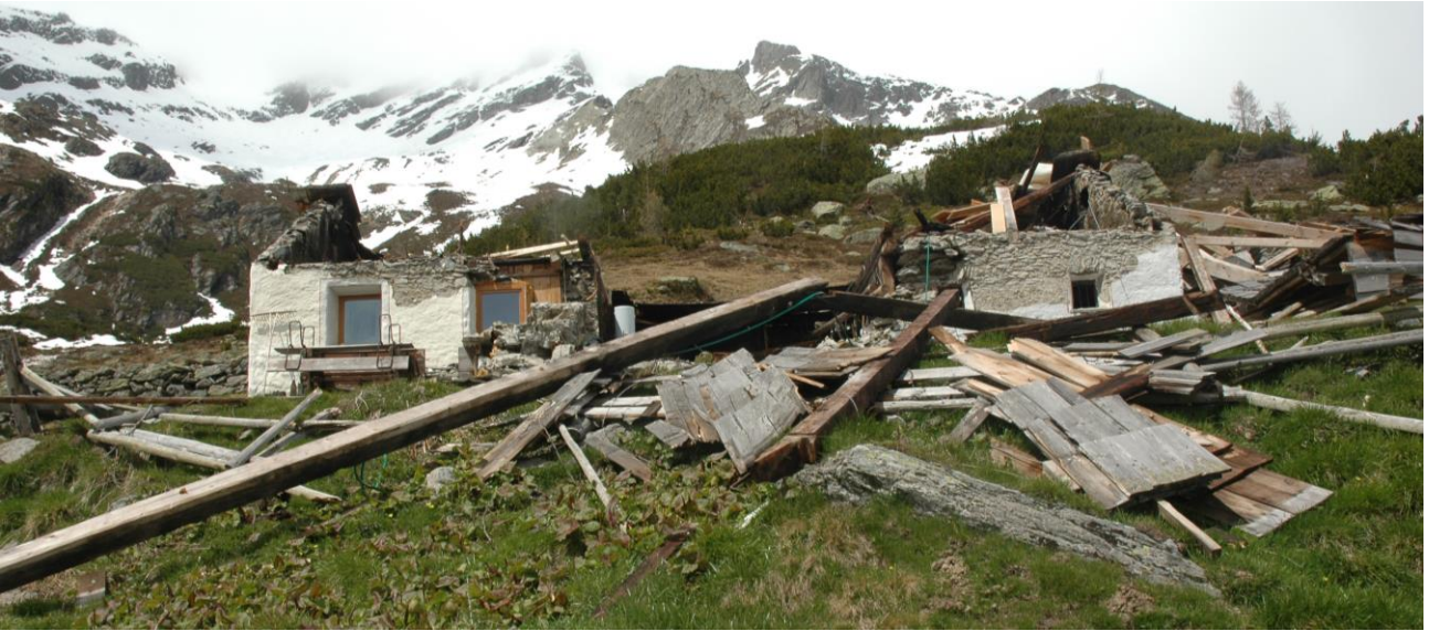
Abbildung 29: Zerstörte, mehr als 200 Jahre alte Moosmeieralm mit Anbruchzone im Hintergrund
