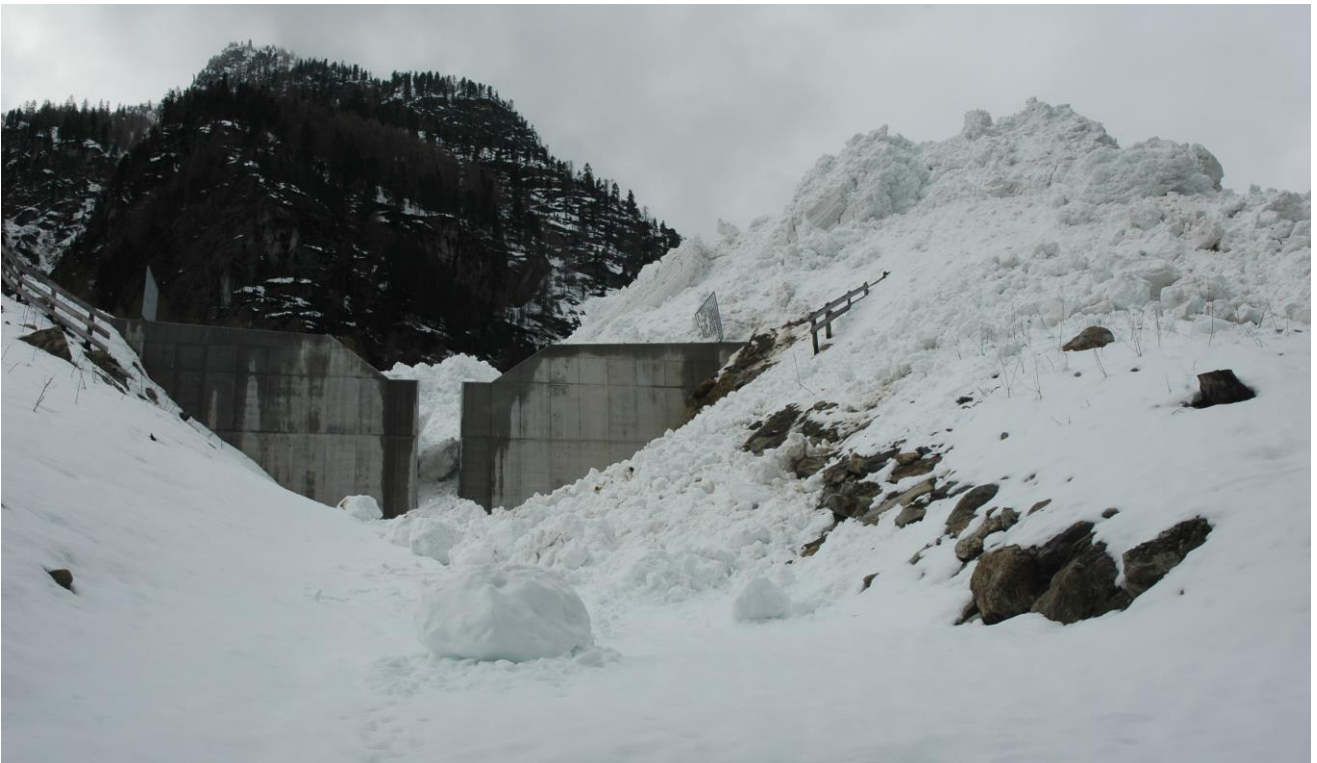
Abbildung 43: Die Murgang Rückhaltesperre des Breitlahngrabens hat ein Auffangvolumen von 35000\text{m}^3 . Die Schneemassen türmten sich mehr als 10m über die Sperrmauer auf. Das Ablagerungsvolumen der Broatlahn wurde auf mehr als 50.000\text{m}^3 Lawinenschnee geschätzt
