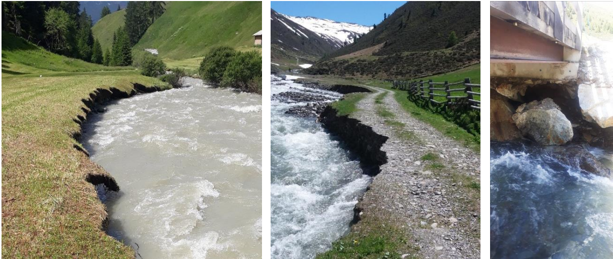
Abbildung 8: Erosionserscheinungen an Infrastrukturen und Flächen in Flussnähe (links Erosion am Karlinbach, in der Mitte und rechts Schäden die vom Pitzbach verursacht wurden)
