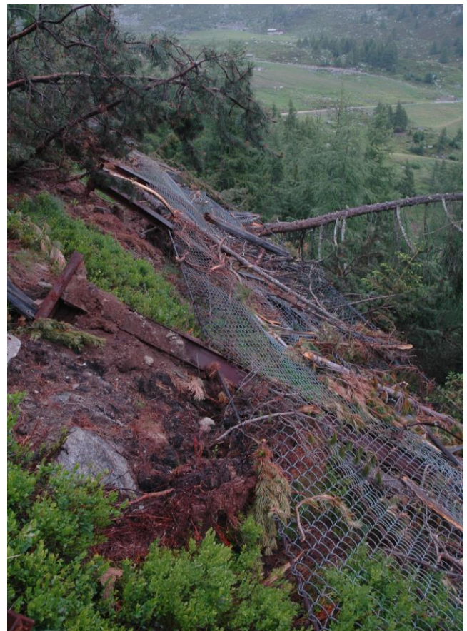
Abbildung 34: Zerstörter Triebsschneezaun mit Rauchkofelspitze (links). Vom Luftdruck umgelegter Schneezaun (rechts)
