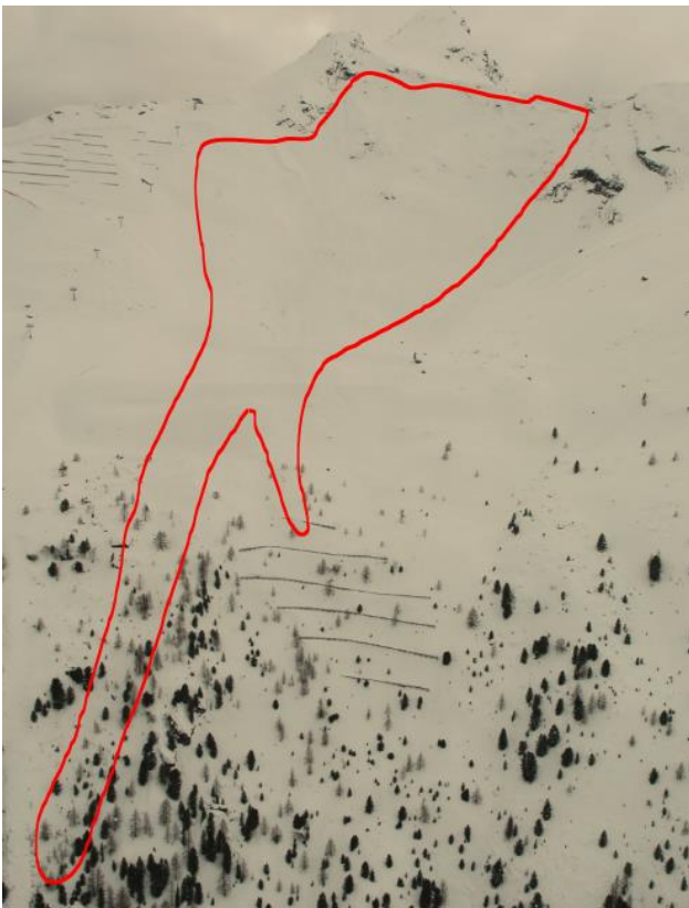
Abbildung 41: Die Obere Böden Lawine im Skigebiet Pfelders überfährt beide Lawinenauffangdämme (links). Ein über 1500kg schwerer Zyklostein wurde beim obersten Lawinenauffangdamm von der Zyklosteinmauer auf die Dammkrone befördert (rechts)
