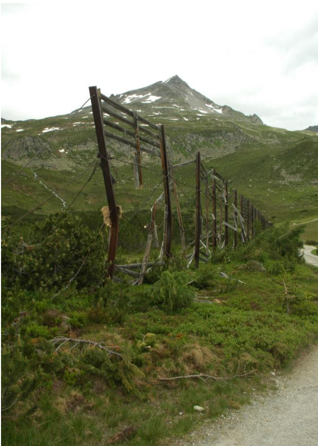
Abbildung 34: Zerstörter Triebsschneezaun mit Rauchkofelspitze (links). Vom Luftdruck umgelegter Schneezaun (rechts)
