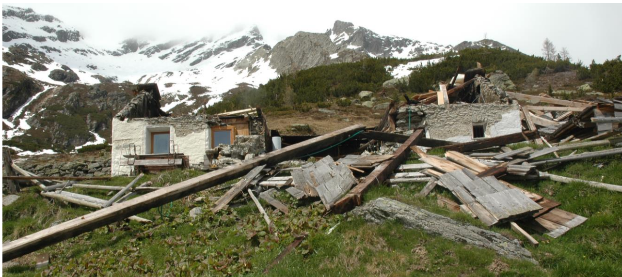
Figura 29: malga Moosmeier (costruita più di 200 anni fa) distrutta dalla valanga con la zona di distacco sullo sfondo
