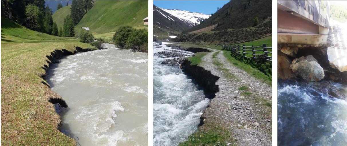
Figura 8: i fenomeni di erosione ad infrastrutture e terreni prossimi al fiume (a sx erosioni sul Rio Carlino, al centro e a dx i danni provocati dal Rio Pizzo di Roia)
