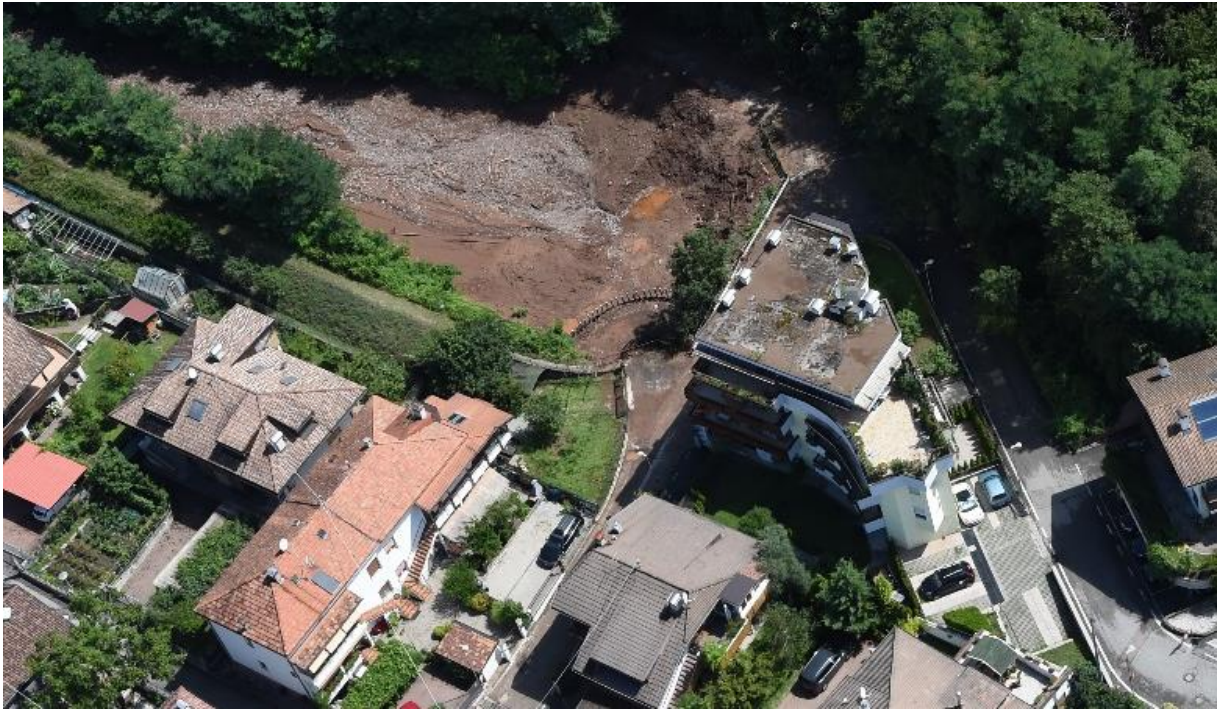
Figura 12: Il bacino di deposito a protezione dell'abitato di Pineta di Laives ha trattenuto efficacemente il materiale
