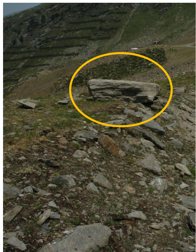
Figura 41: la valanga Obere Böden nel comprensorio sciistico di Plan ha oltrepassato i due argini di contenimento (sinistra). Un masso ciclopico pesante più di 1500 kg è stato asportato dalla parte sommitale dell'argine (destra)
