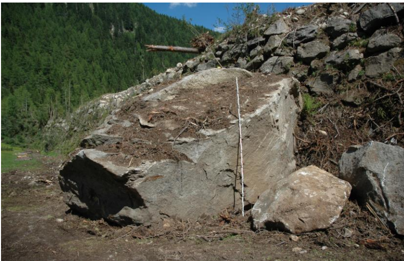
Figura 32: massa di ca. 100 tonnellate trasportato a valle per 100m. I massi ciclopici posti nella parte alta dell'argine sono stati parzialmente asportati. (sinistra)
