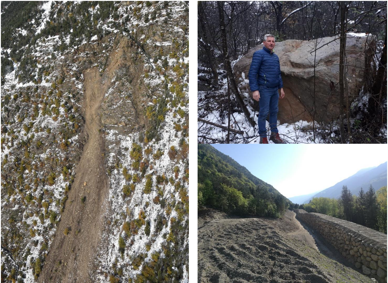
Figura 20: A sinistra, la nicchia di distacco e il percorso di crollo dell'evento. A destra uno dei blocchi di crollo e i tomi-valli ultimati sul lato monte della strada statale della Val Venosta
