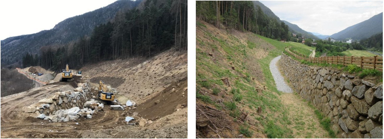
Figura 19: La foto a sinistra mostra la costruzione del vallo paramassi orientale all'inizio di marzo 2020 (a sinistra nella foto la linea ferroviaria della Val Pusteria), mentre la foto a destra mostra l'opera ultimata (foto dell'estate 2020)
