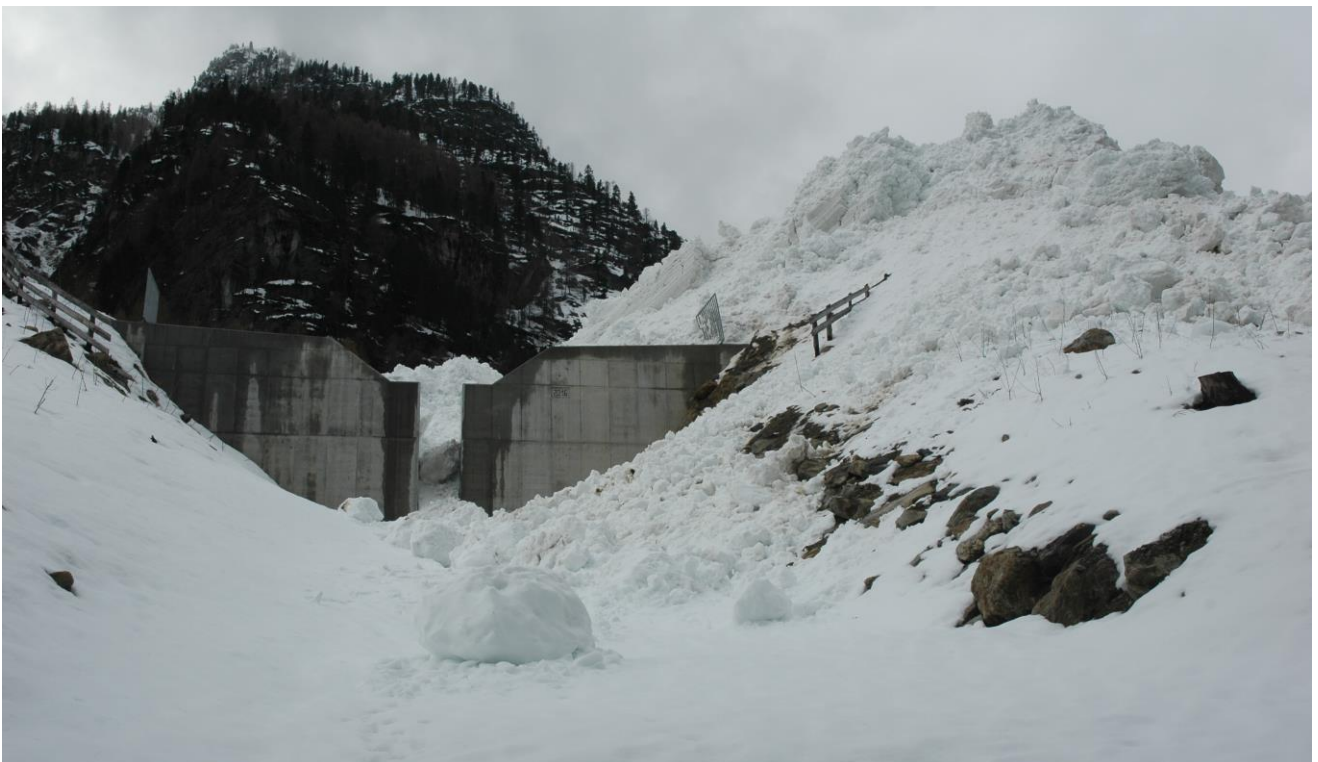
Figura 43: La briglia di trattenuta per le colate detritiche del fossato Breitlahn ha una capacità di ca. 35.000 m 3 . Le masse nevose depositate dalla valanga si sono accumulate per più di 10m sopra l'opera. Si stima un volume di neve depositata pari a oltre 50.000 m 3
