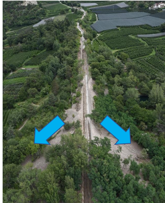
Figura 10: l'esondazione "incontrollata" sulla cunetta del Rio di Vezzano
