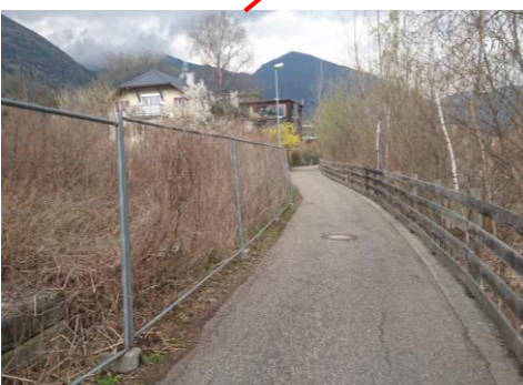
Baustellenrampe zum Eisack
