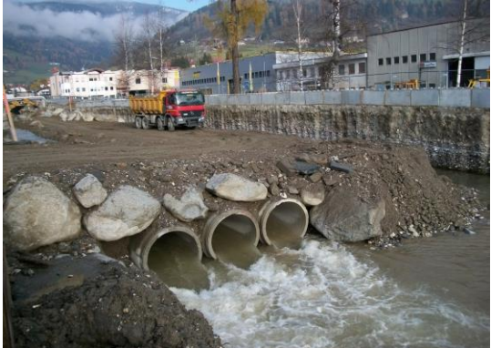
Überquerung des Eisacks in Rohren
