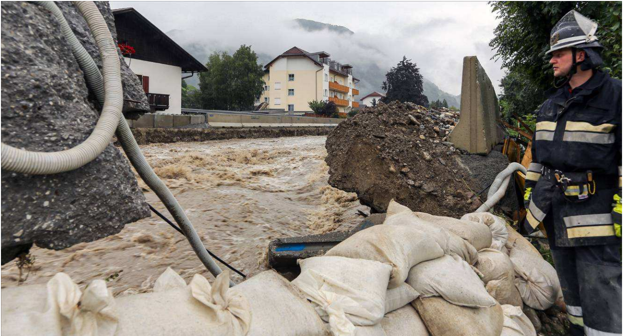
Die Feuerwehr überwacht den rechten Uferdamm des Eisack in Sterzing
