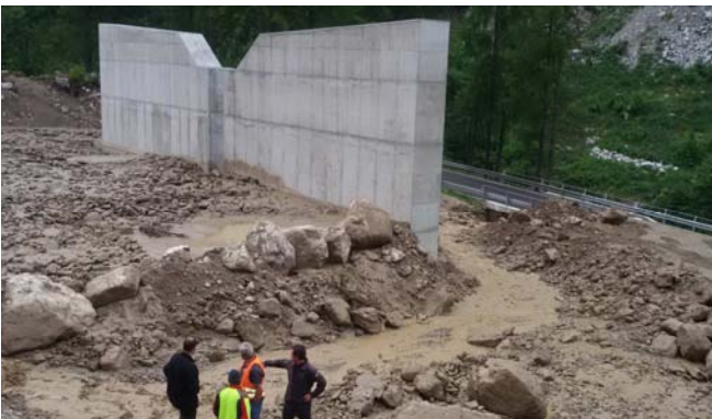
La briglia in costruzione sullo Stachelgraben ha "smorzato" la colata detritica, che ha comunque raggiunto la strada provinciale
