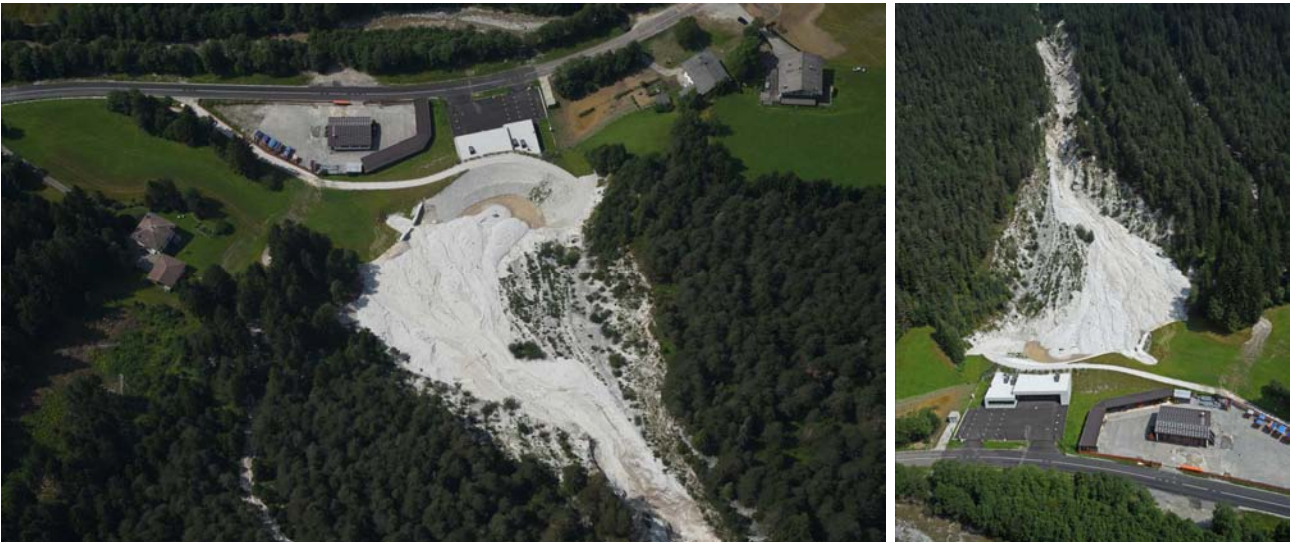
In prossimità di un conoide di colata detritica sono stati realizzati, in tempi recenti, un magazzino per la manutenzione delle strade e la stazione dei viaili del fuoco volontari
