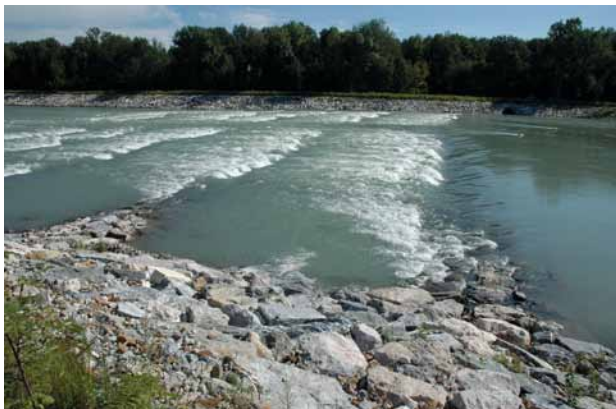
Tav. 4-15: Rampa di suolo valicabile per la fauna ittica (esempio).
